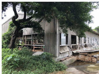
G. 酪農地 牛舎 牛舎／倉庫／酪農業設備／植栽／牧草地
