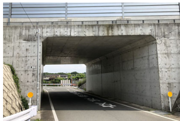
G. 東九州自動車道高架下
