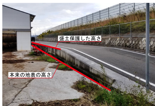
図 8-2-1 遺構保護のための盛土 (福原長者原官衙遺跡)
