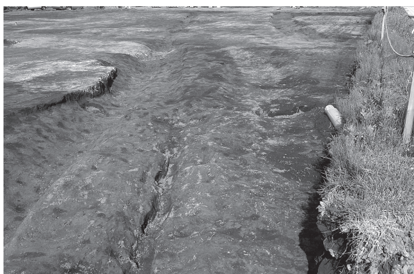
1号道路 硬化面 西から
