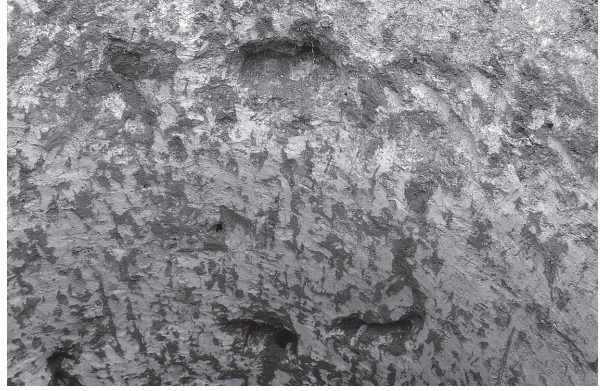
2号井戸 足掛けピット 近景
