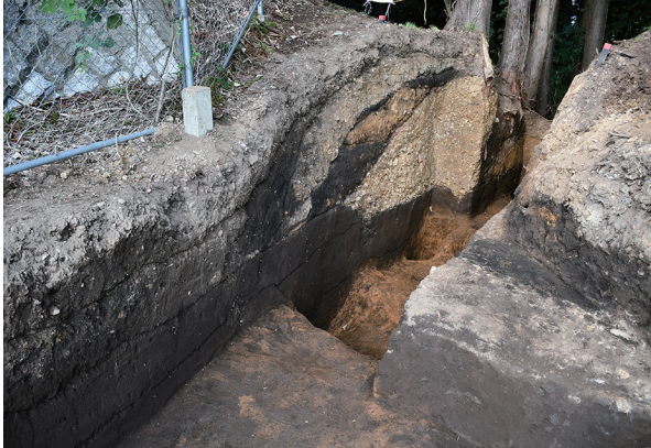
SA01 構築状況 (南から)
