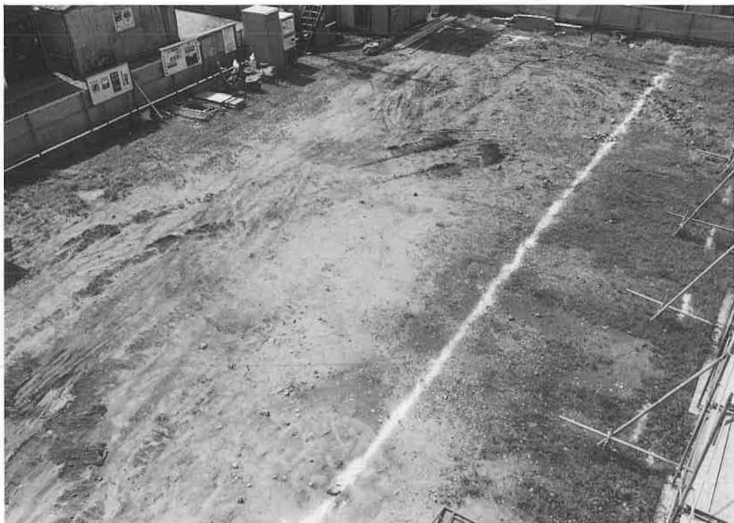
1. 調査前の状況
