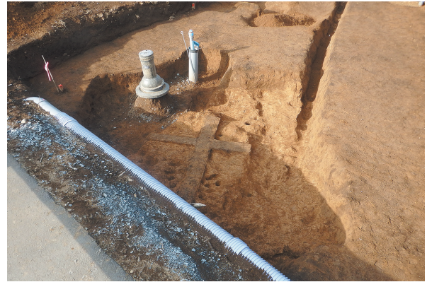
第1号竖穴建物跡掘方完掘状況（南方向から）
