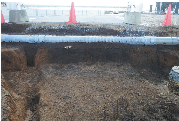
第1号竖穴建物跡土層断面（北方向から）
