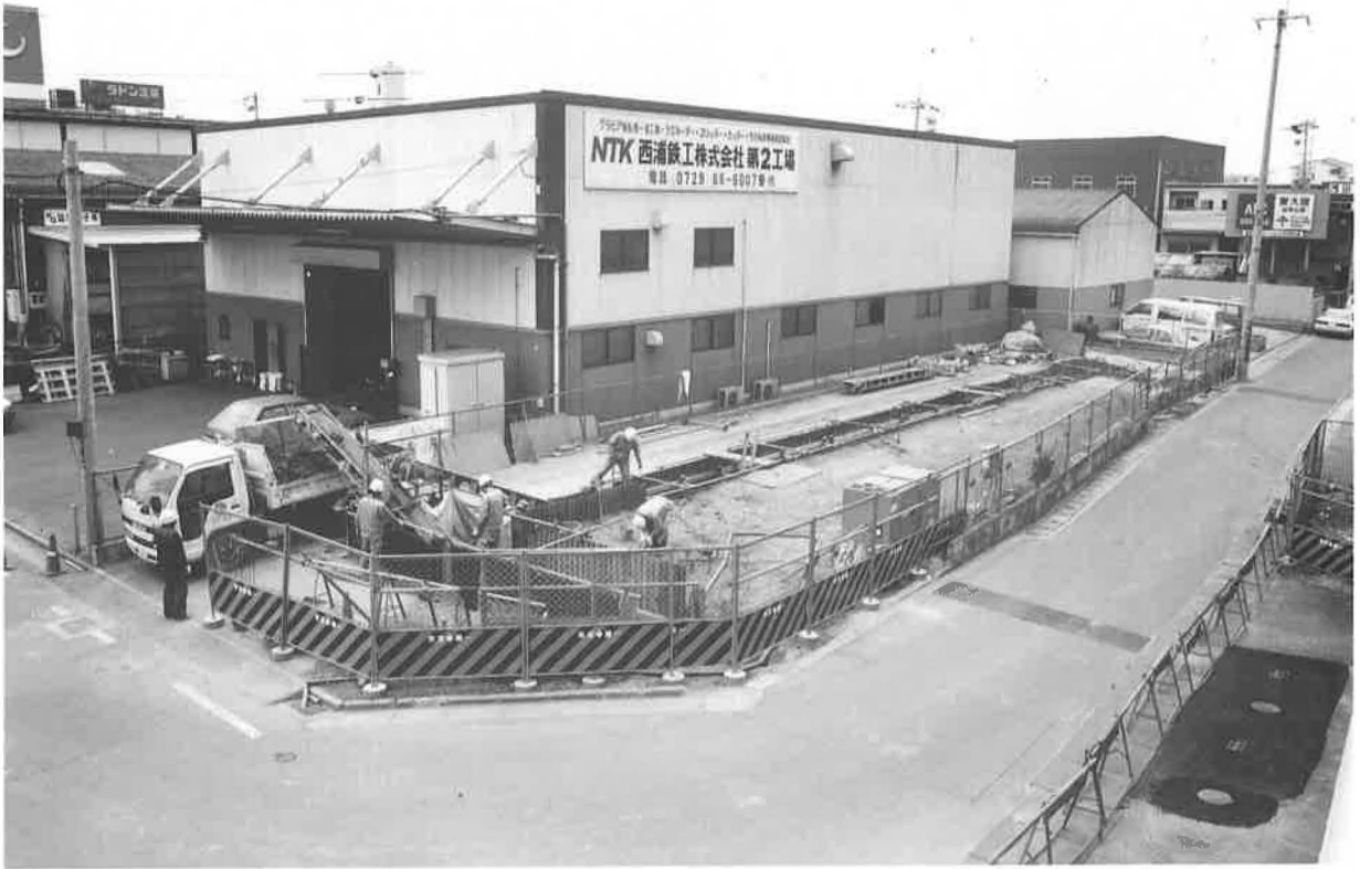
下水管移設部分調査地全景（北東より）
