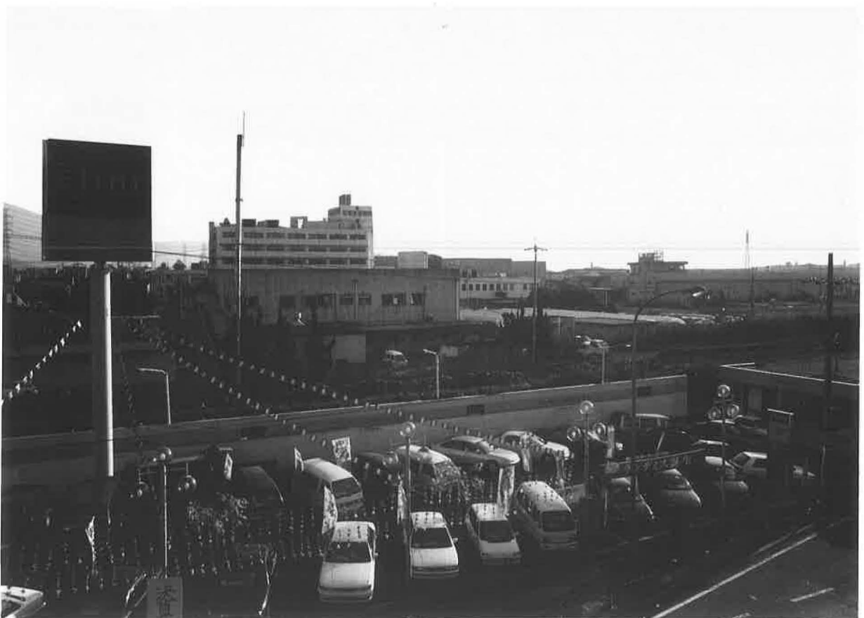
第1ピットより第7次調査地点を望む（北より）
