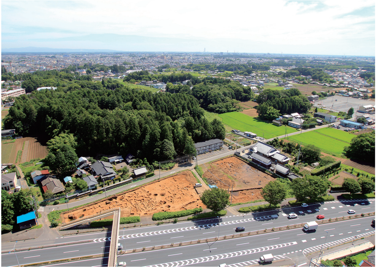
河和田城跡と調査地点（南西から水戸市街を臨む）
