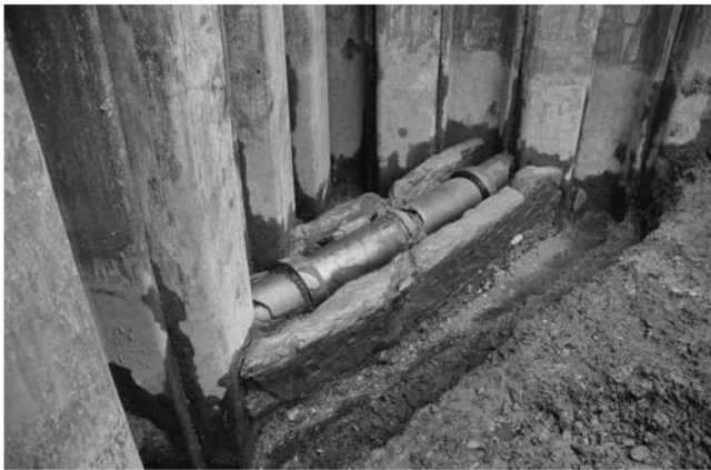
写真50 土管設置状況 (北から)
