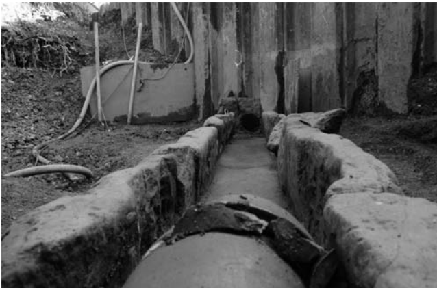
写真43 柁石割り抜き状況（北から）
