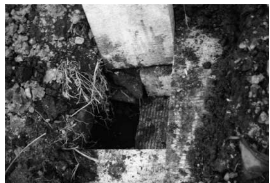
写真58 第15地点岩樋補修状況
