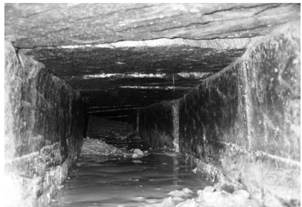
写真28 トレンチ4上蓋A付近岩樋内部（西から）
