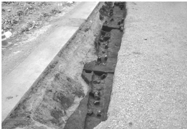
2区2号溝遺物出土状況 (東より)
