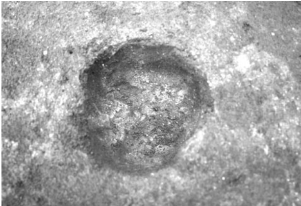
3区26号ピット完掘（南より）
