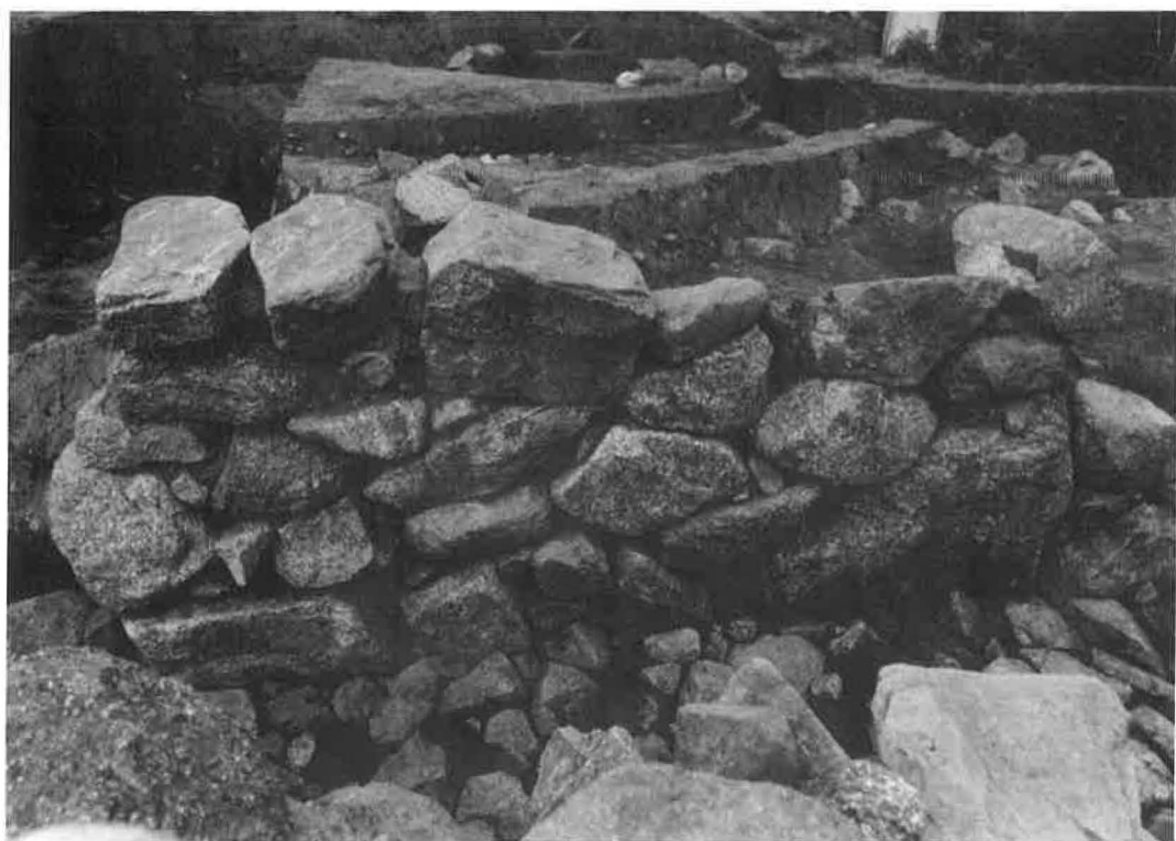
2. 石室右側壁(部分)
