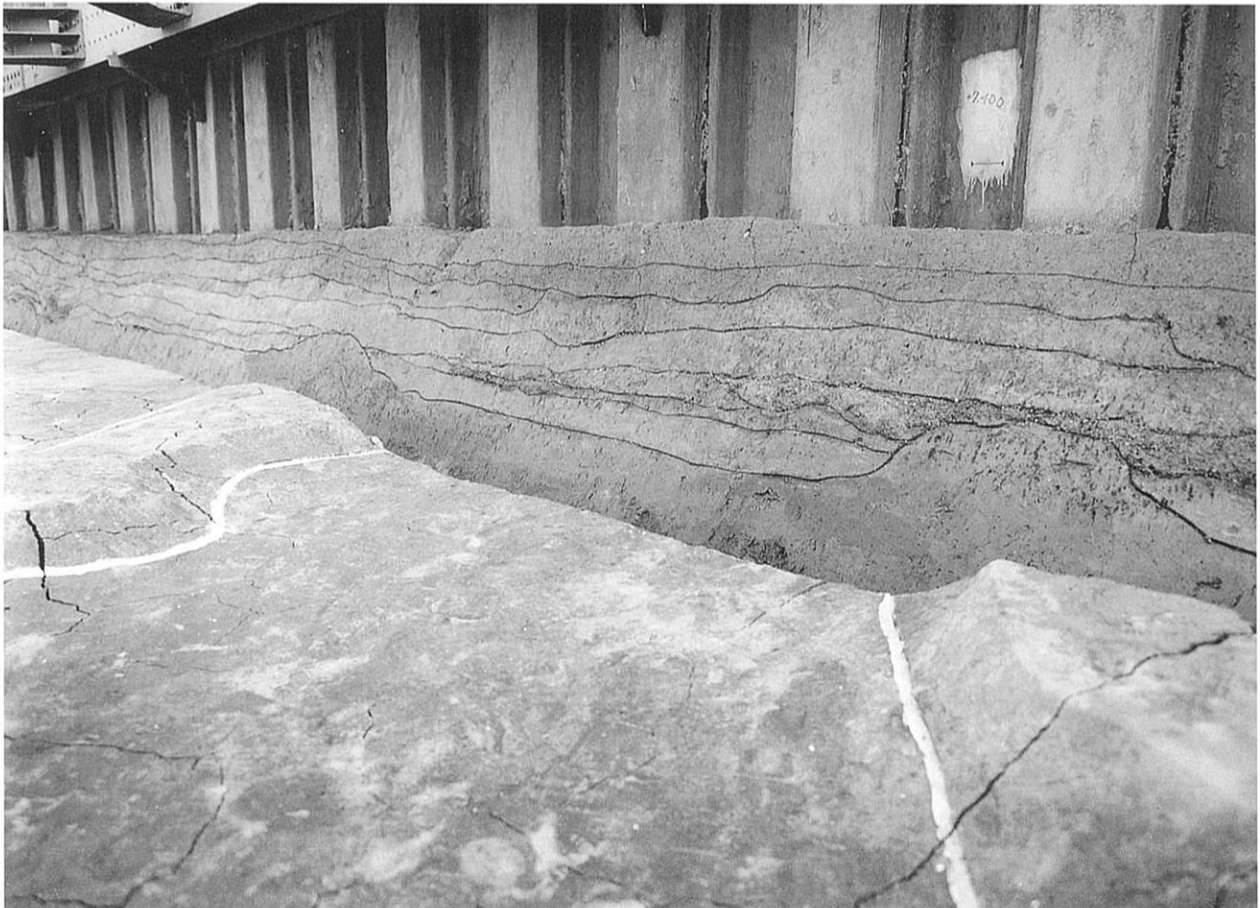
堤断面（北西から）
