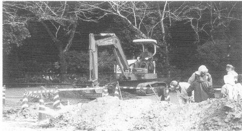
C地点重機による表土剥ぎ
