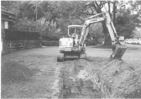
B地点重機による表土剥ぎ
