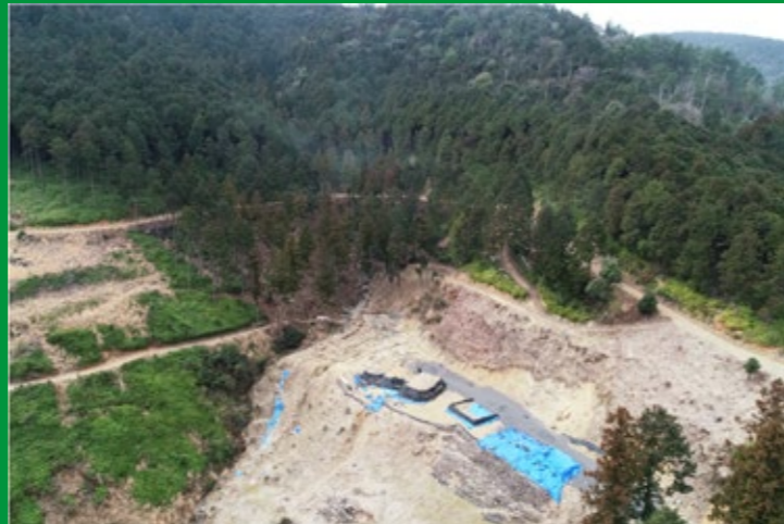
平坦部A全景（北東上空より）
