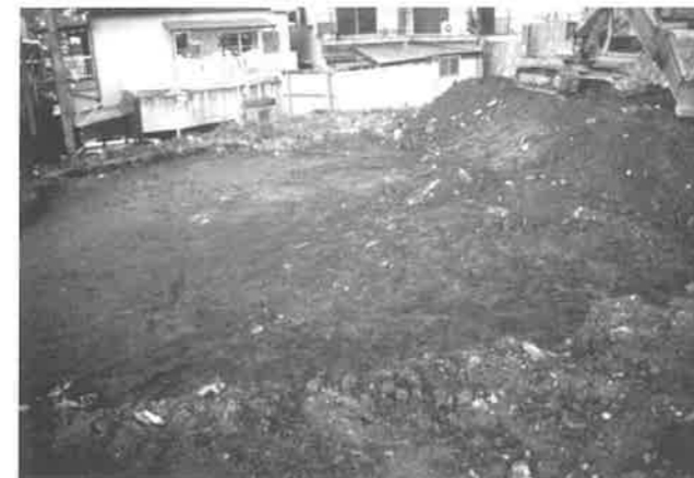
図5 A地区機械掘削 西から
