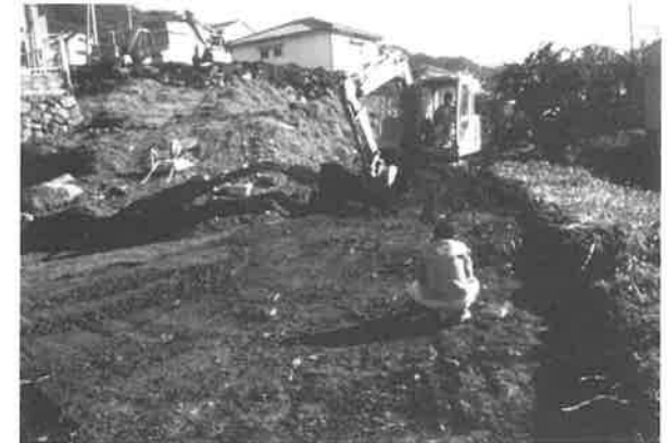
図55 C地区機械掘削 北から
