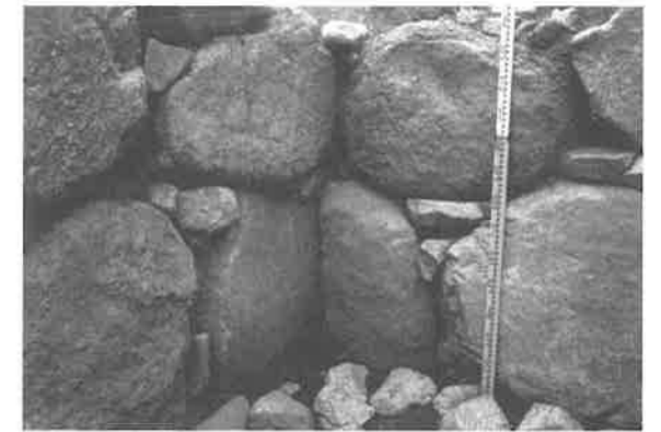
図72 30号墳奥壁 北西コーナー
