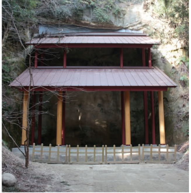
写真 55 平成 26 年度工事竣工
