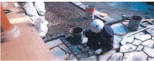
写真 58 平成 28 年度工事（外構仕上げ工事等）
