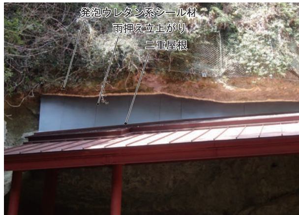
写真53 屋根と岩の取り合い
