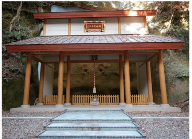
写真 59 平成 28 年度工事竣工
