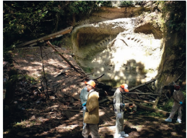
写真1 倒壊した観音堂石仏覆屋
