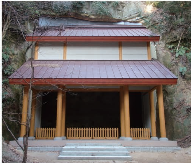
写真 57 平成 27 年度工事竣工
