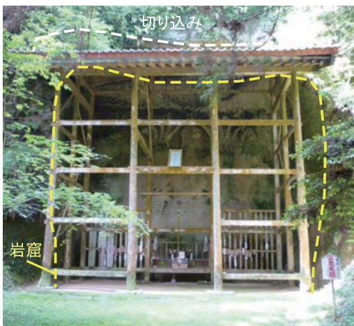
写真 37 a期覆屋 (S34~H23)
