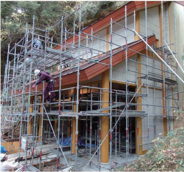
写真 56 平成 27 年度工事（内装・外構工事）
