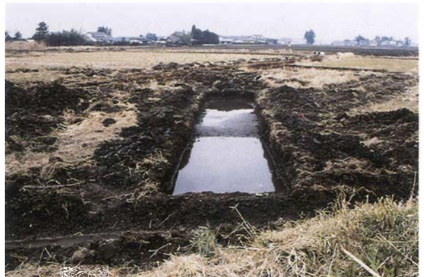
22 調査区南西側試掘トレンチ(北東から)
