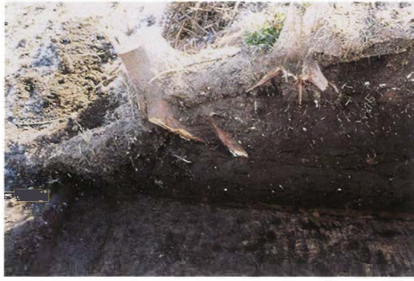
17 糠塚 4号トレンチ土層断面(西から)
