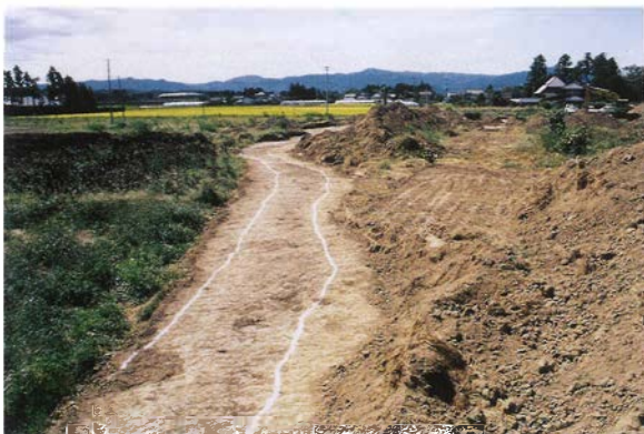
7 微高地南辺検出状況(東から)
