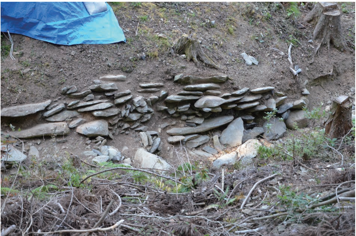
2 石積みSW003-1 (南より)
