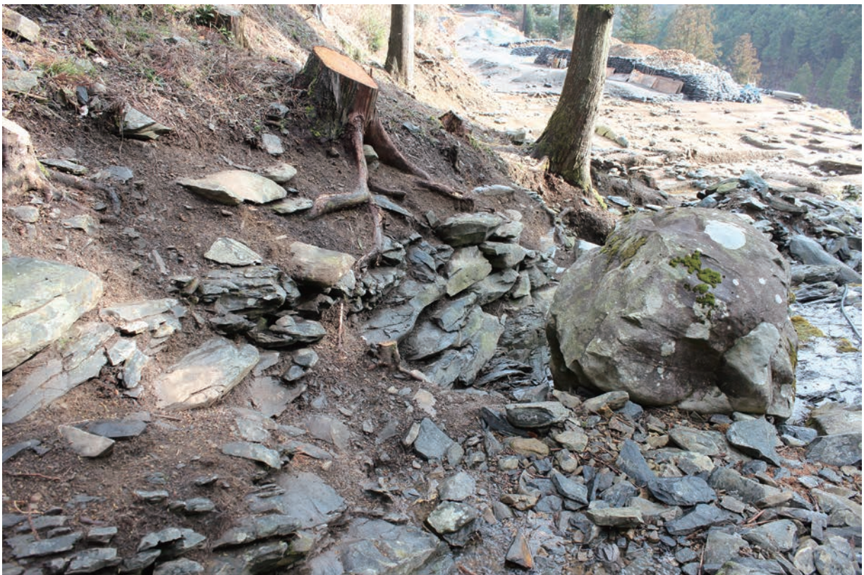
2 石積みSW003-3 (西より)
