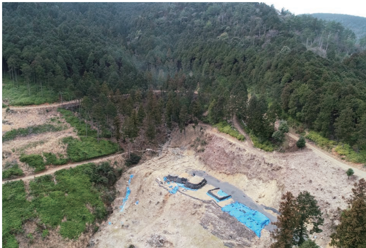
1 平坦部A（如意頭院跡）全景（北東上空より）
