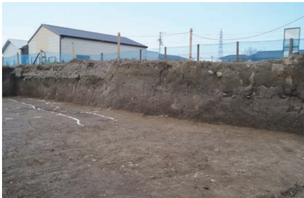
1区北壁(A-A'-A'')西半断面(南東より)
