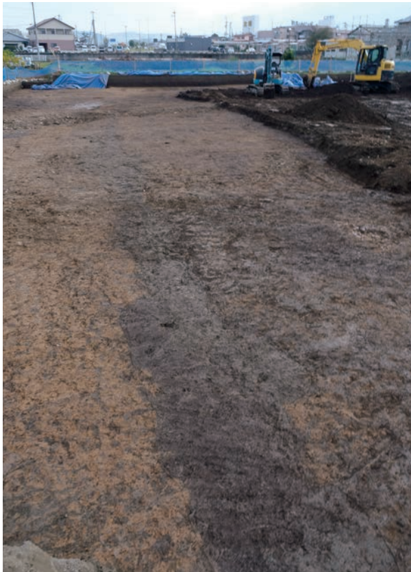
2a区北側遺構検出状況(西より)
