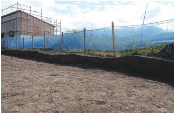
2a区南壁(E-E'-E'')東半断面(北西より)
