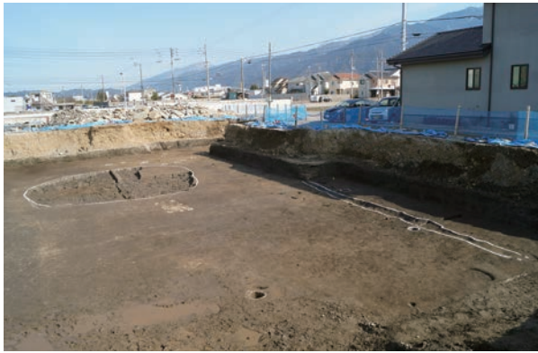
2区南半完掘状況(北西より)
