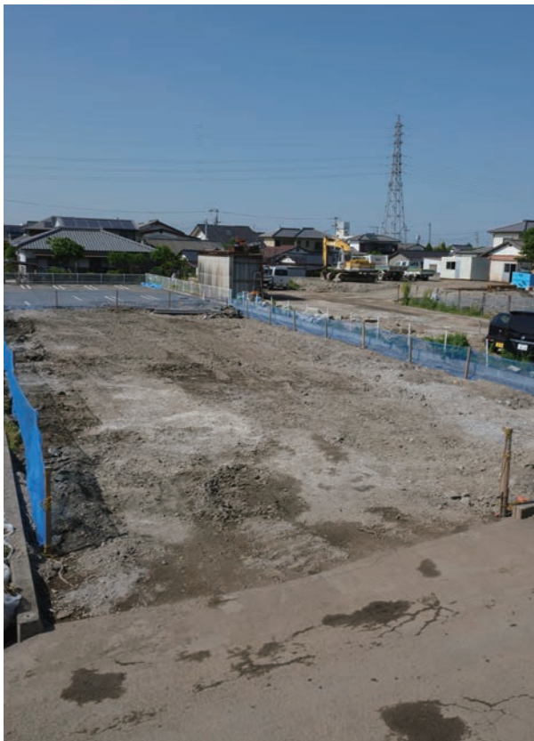
1区西側調査前状況(南西より)
