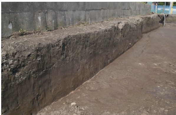
1区西壁(B-B')断面(南東より)
