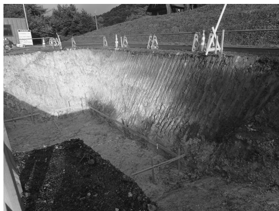
川樋大字大洞山 北・東壁 (南西より)
