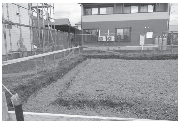
若狭郷屋字沢見 掘削状況 (南より)
