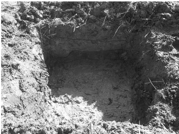
三間通字諏訪西 TP4（北より）
