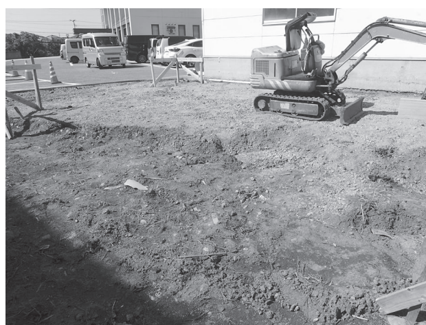
三間通字西唐越 掘削状況 (南東より)
