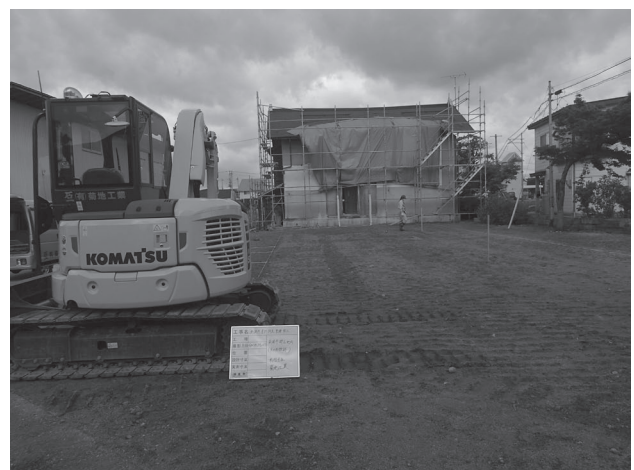
矢ノ目館跡 調査区全景(東より)
