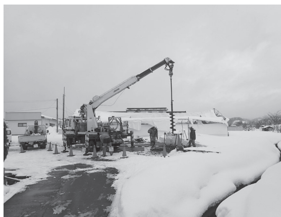
宮内字湯街道二 掘削状況（南より）
