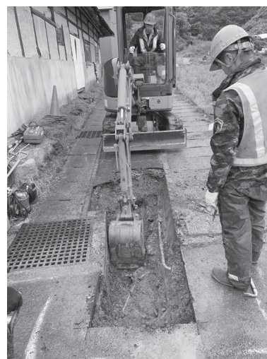
北町遺跡 工事全景 (東より)
