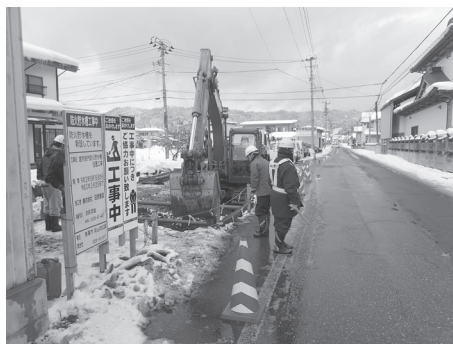
久根崎遺跡隣地 重機掘削状況 (南東より)
