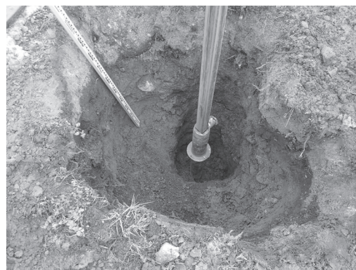
宮内字湯街道二 掘削孔（西より）
