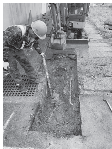
北町遺跡 掘削終了 (東より)
