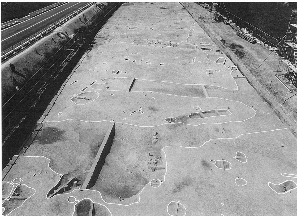
3 E区南 溝 250001 (南東から)
