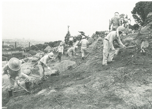
第36図 A4区表土除去
