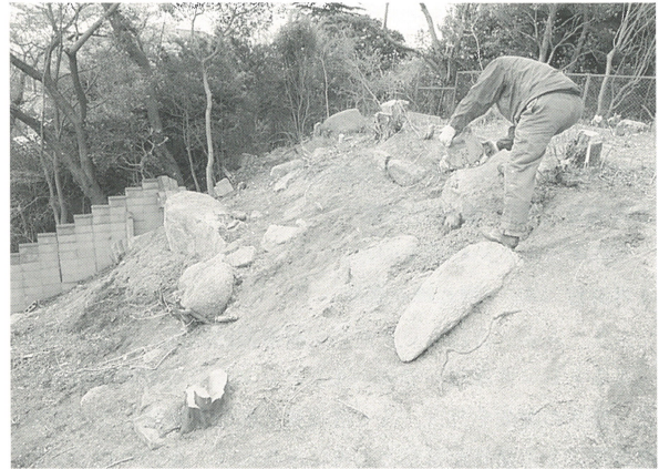
第34図 急斜面部分の防災工事
