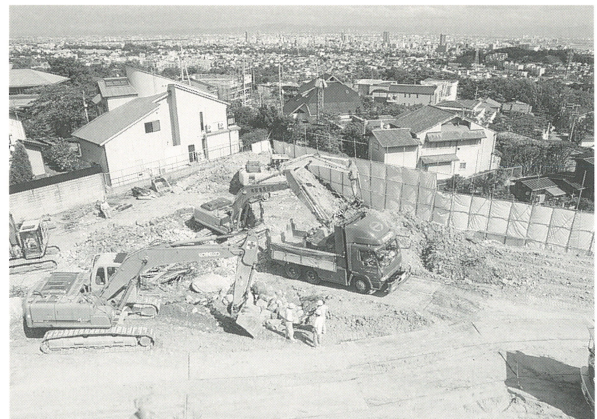
第55図 造成工事
