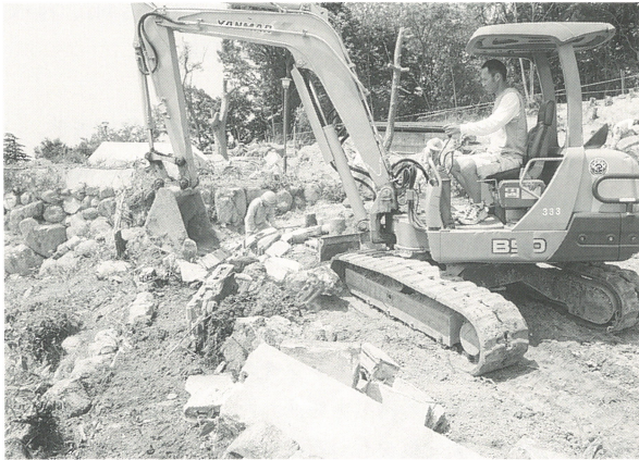
第37図 重機による近現代石垣の除去
