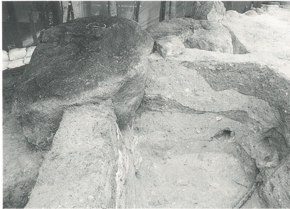
第24図 岩ヶ平刻印群(第79地点)で検出した埋設管と移動石材
