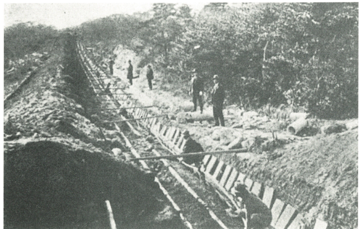
第23図 六麓荘開発時の水道・ガス・電気埋設工事 〔芦屋市1991b〕
