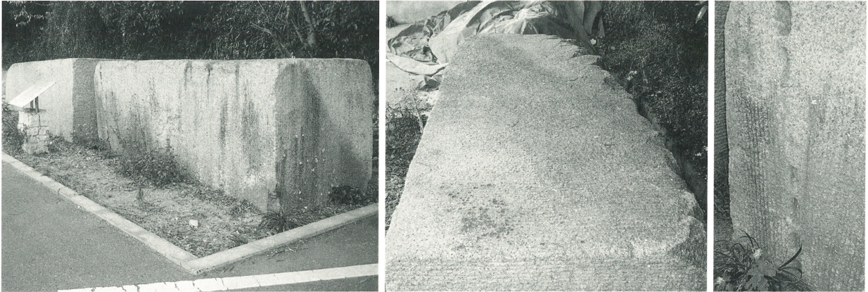
第2図 室津の石垣用石材 ノミ調整や矢穴が確認できる
