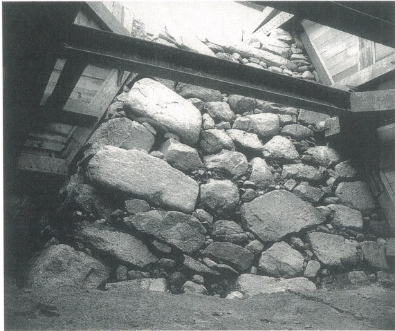
第3図 豊臣大坂城本丸石垣の発見状況 〔大阪市文協編 1985〕から
