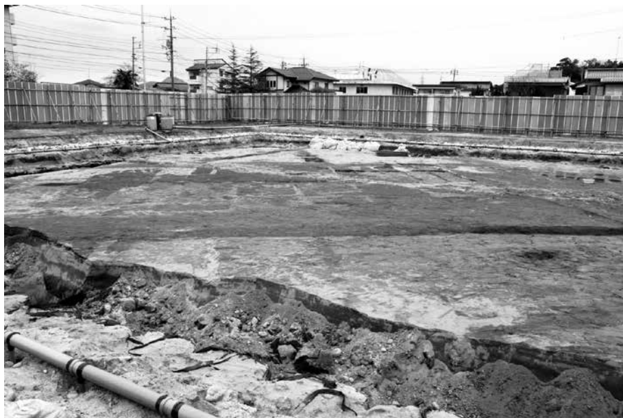
2区北部第2・3層上面 検出状況（西から）
