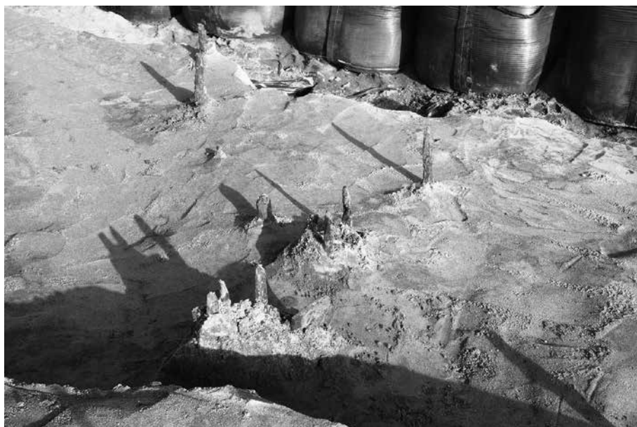
SD11・13 合流部杭群 (西から)
