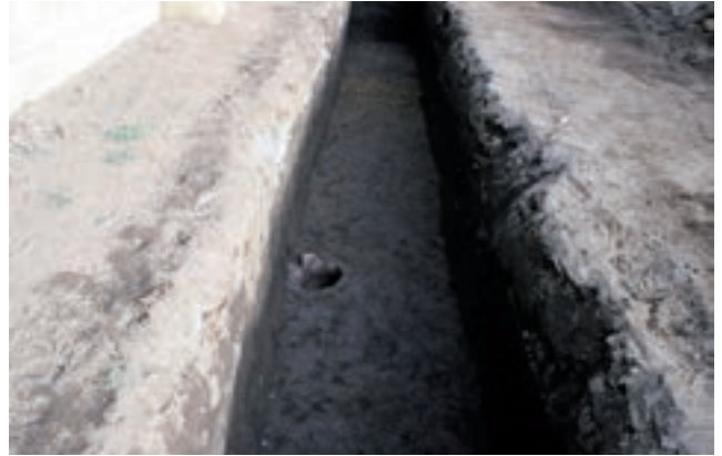
2. No.1調査区調査状況(西から)
