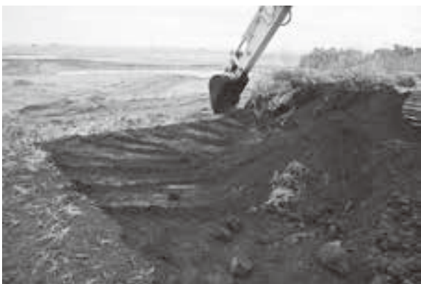
写真8 調査区北東端表土除去 (5/27北西から)
