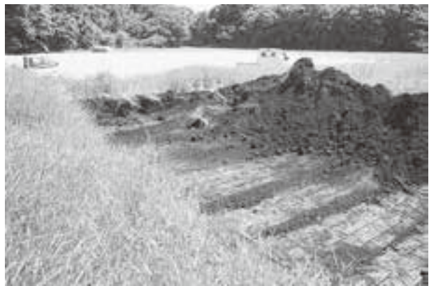
写真7 調査区北西端表土除去 (5/26南西から)
