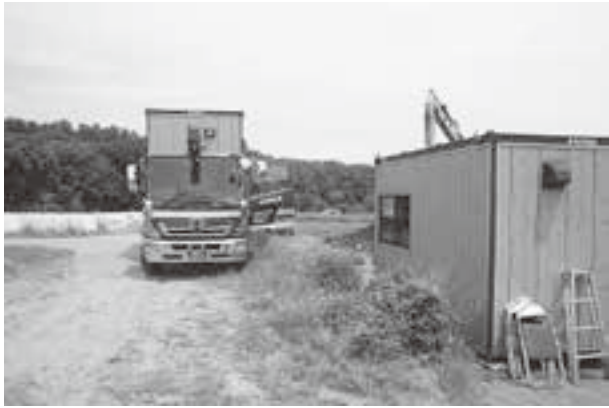
写真10 プレハブ搬入作業 (6/1 南西から)
