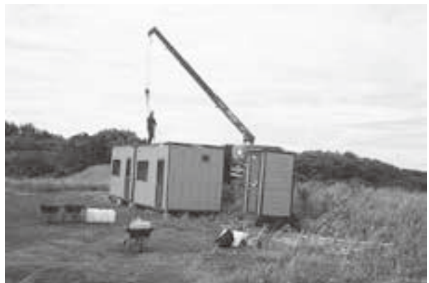
写真25 プレハブ撤去 (8/31北東から)
