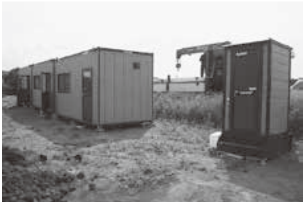
写真12 プレハブ・トイレ設置状況 (6/1 北東から)
