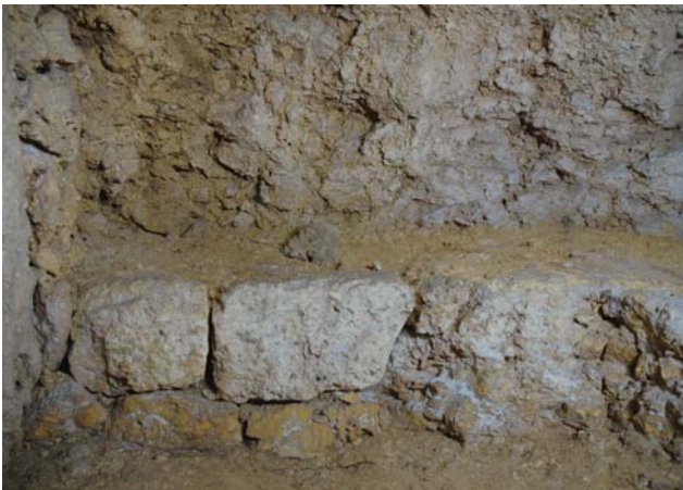
墓室内 右側 [北西より]
