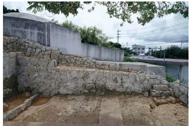
左側 庭積み一庭囲い〔北東より〕
