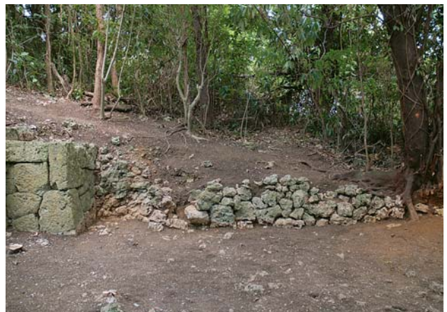
左側 庭囲い〔南西より〕
