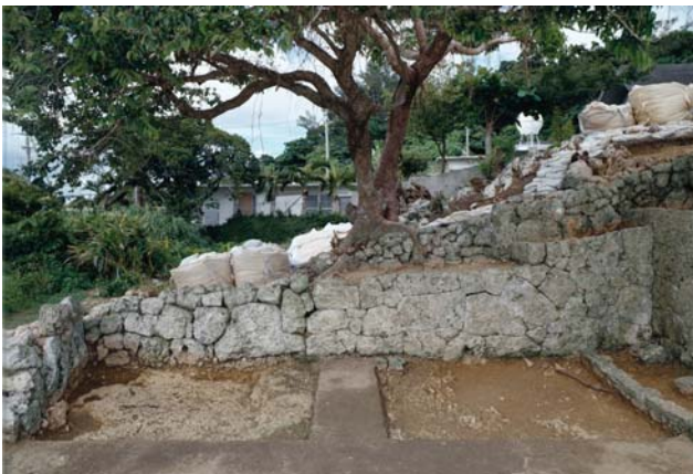
右側 庭積み一庭囲い〔南西より〕
