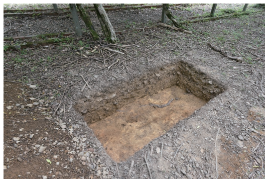
5. W-4トレンチ完掘状況(北から)
