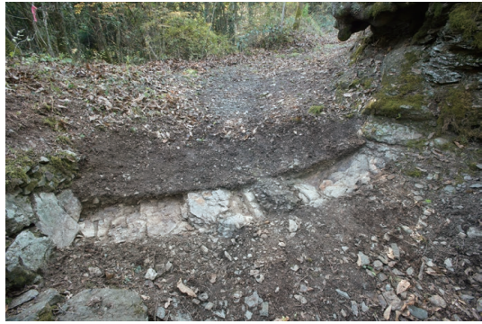
2. 夜昼峠越6トレンチ完掘状況(北から)
