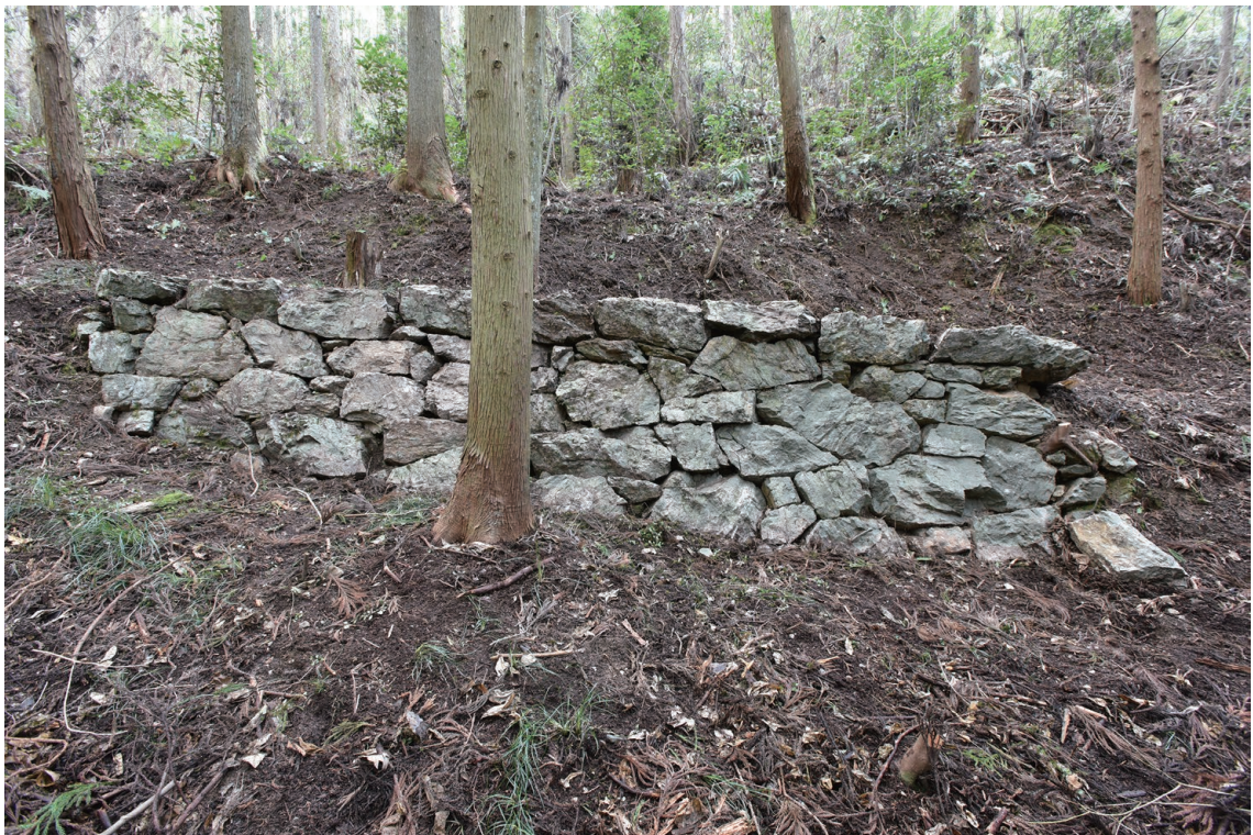
3. 夜昼峠越3トレンチ調査前状況・石積1(北東から)
