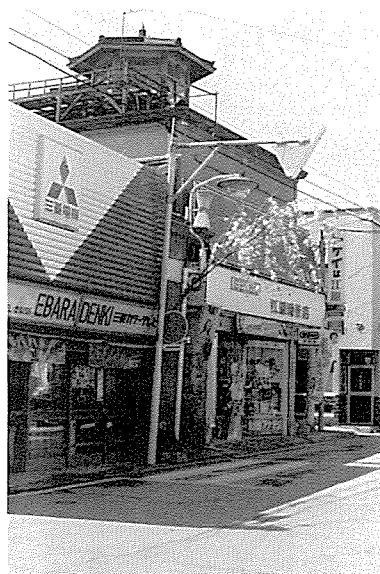
富岡市内 旧消防望楼
