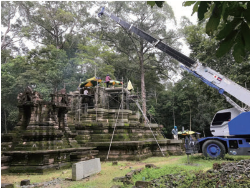
第7図 中央祠堂修復作業風景 (北西から)
