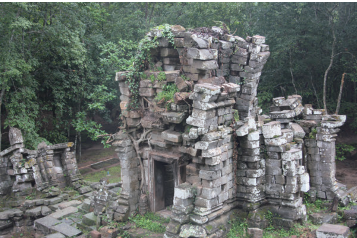
第10図 中央祠堂躯体部上部解体前状況（北東から）
