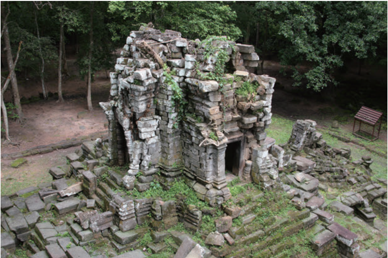
第 5 図 中央祠堂修復前状況（南東から）
