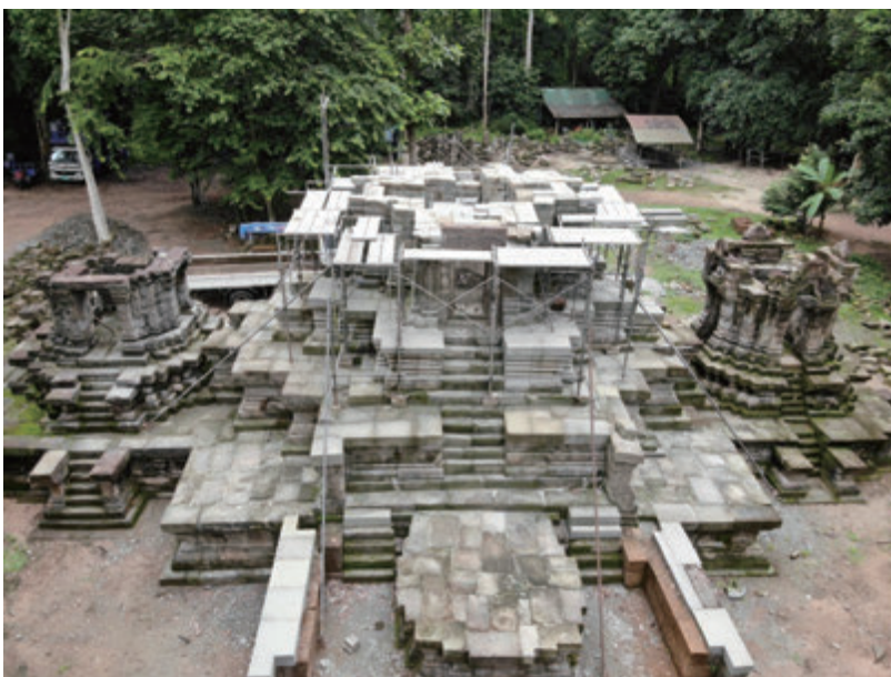
第8図 中央祠堂修復作業風景 (東から)
