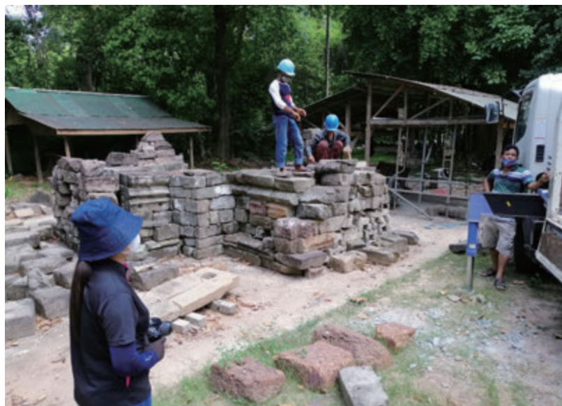
第11図 中央祠堂躯体部上部仮組風景（南東から）
