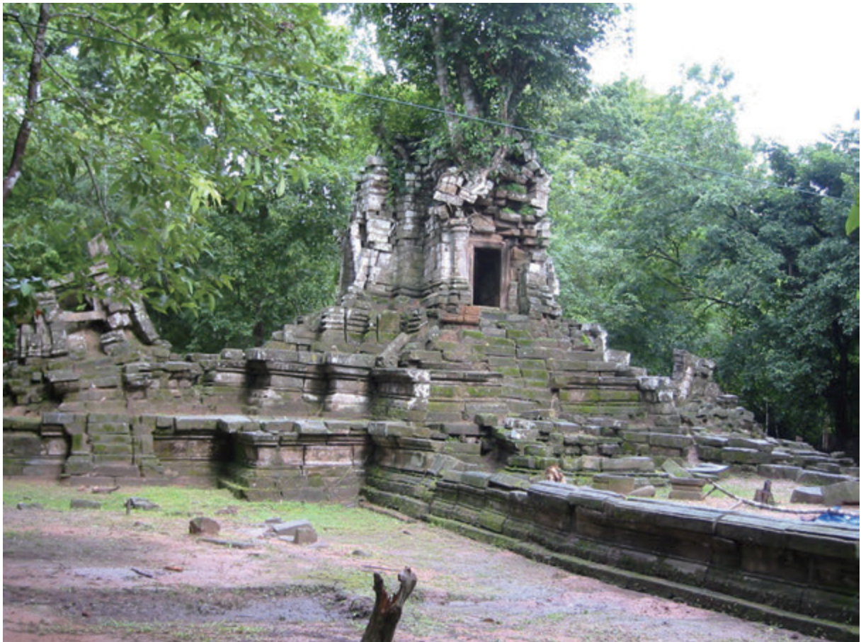
第1図 西トップ遺跡修復前風景（南東から）
