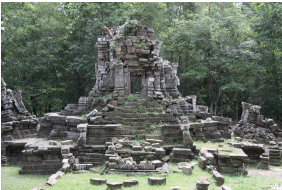
第3図 中央祠堂修復前状況（東から）
