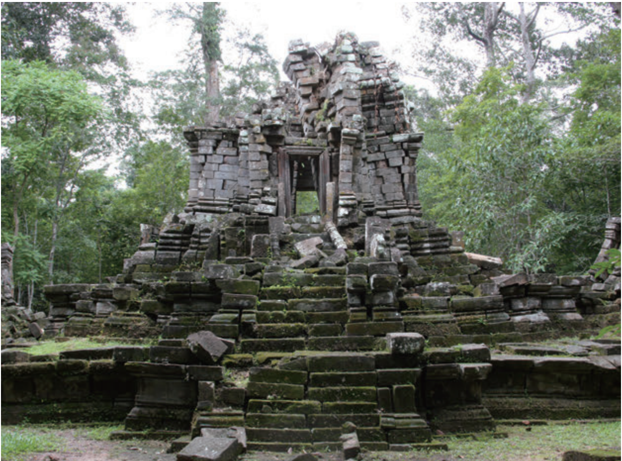
第 6 図 中央祠堂修復前状況（西から）
