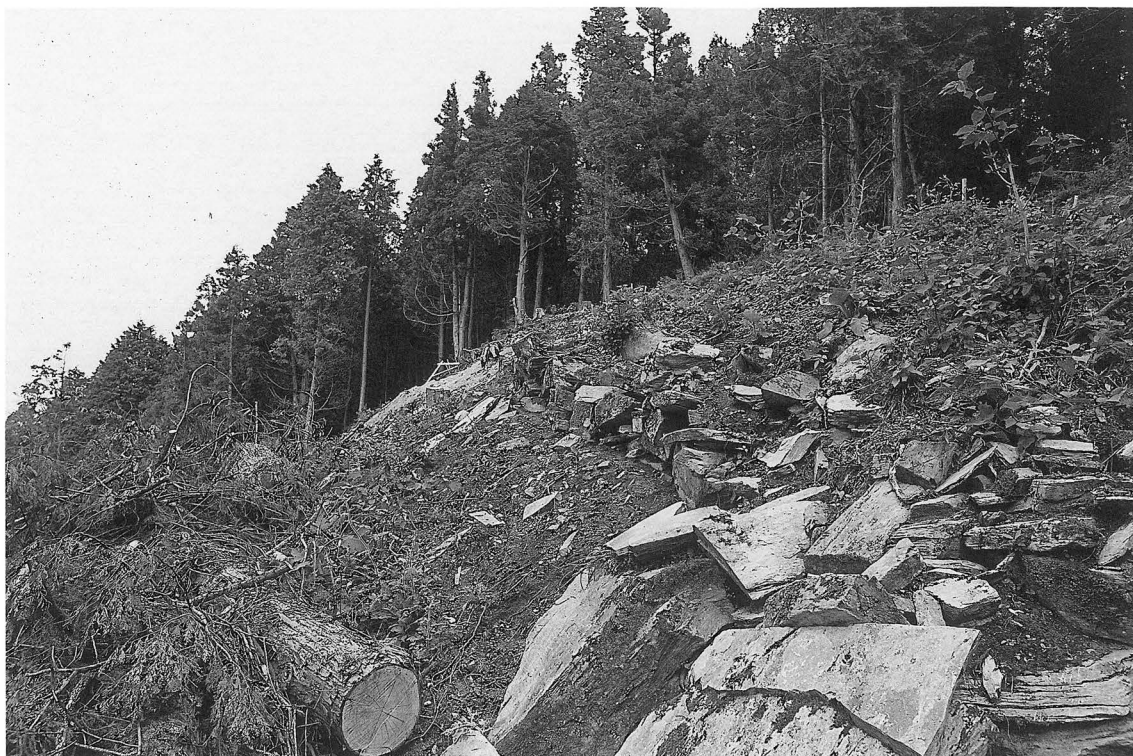
郭5 石積み（調査区外）の現況（西から）
