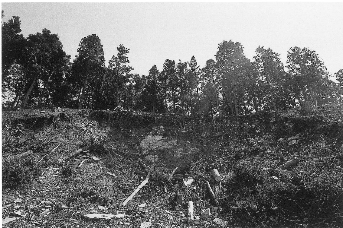
調査前状況（林道側から）
