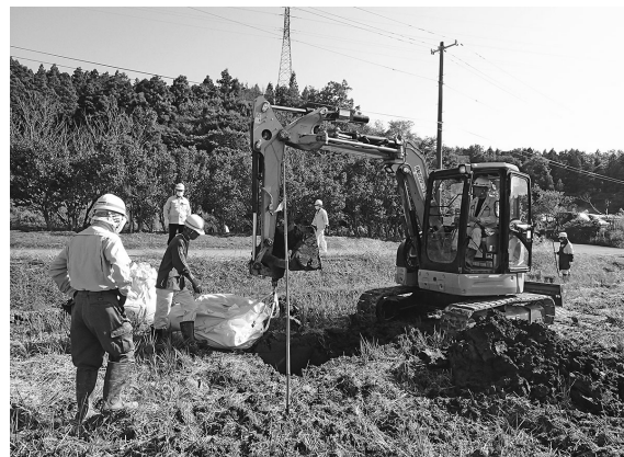
写真4 調査風景(埋戻し)
