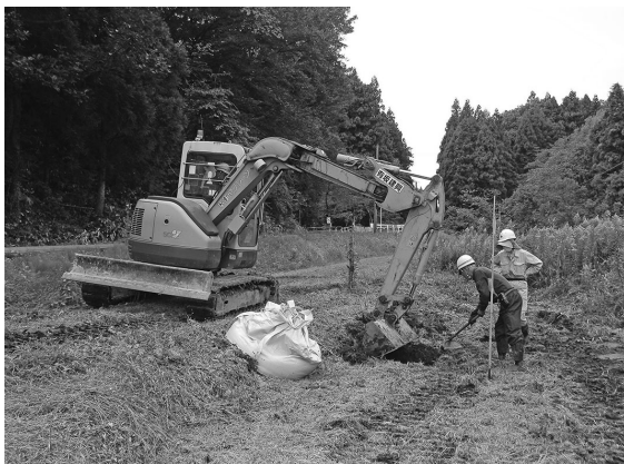
写真3 調査風景(掘削)
