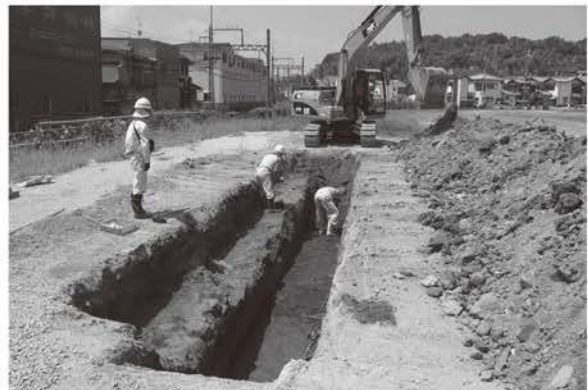
写真4 トレンチ3 調査の様子（北から）
