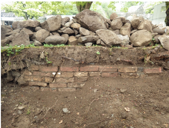
工事① 煉瓦建物No. 1 検出状況 (南から)
