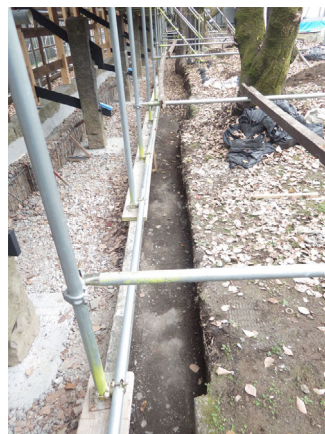
工事⑥ 施工前状況東端部（東から）
