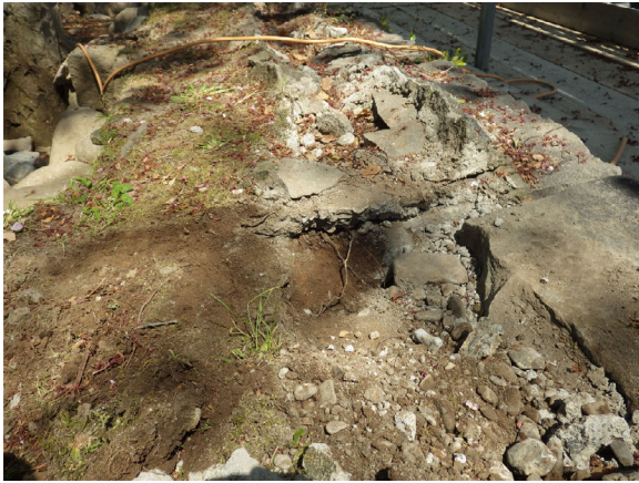
基礎石土台部断面 基礎No. 8 東壁付近 (西から)
