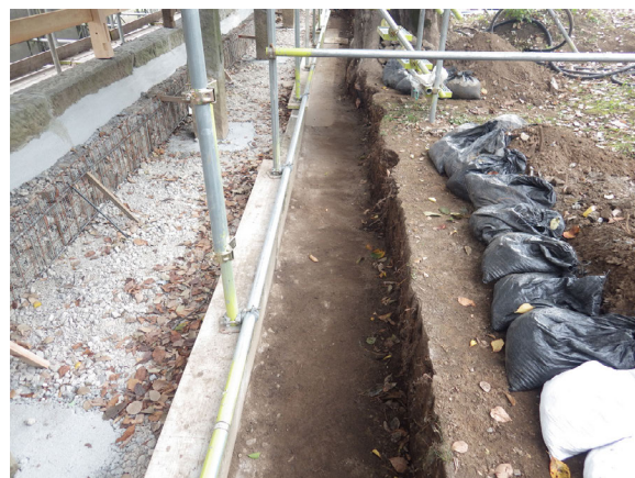
工事⑥ 対象地中央付近掘削等完了後（東から）
