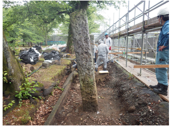
工事③ 建て起こし作業中の柱と被災した柱
