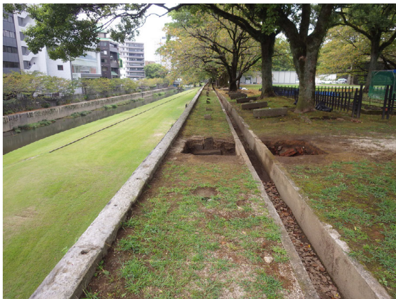
トレンチ 12 調査前状況（東から）
