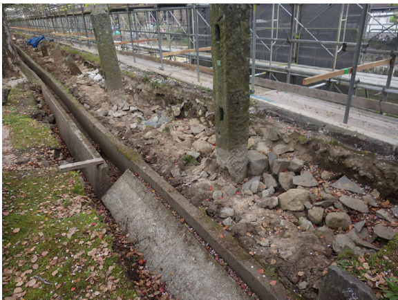
工事④ 解体終了後 (北東から)
