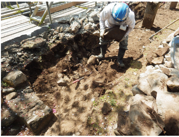
工事① 掘方整形 栗石などの掘削
