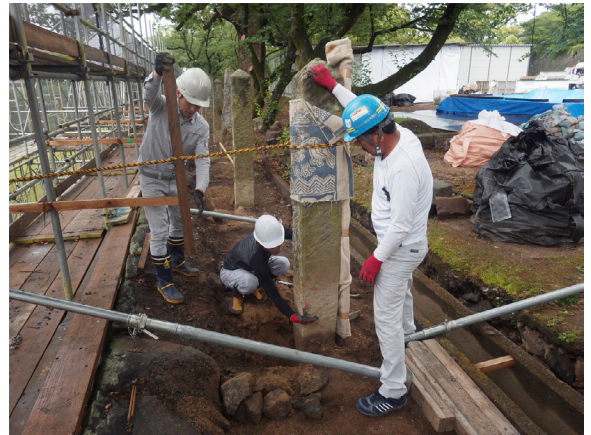
工事③ 建て起こし作業
