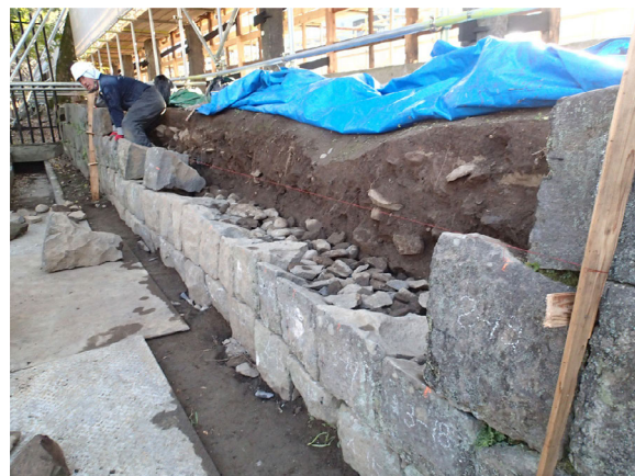
工事④ 石積作業状況
