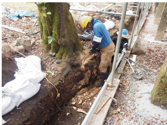
工事⑥ 樹根の切断と掘削
