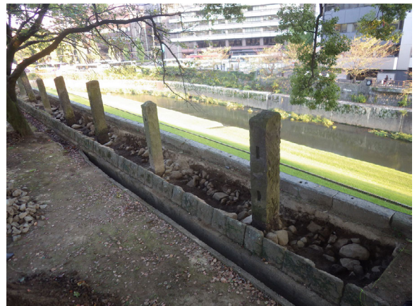
トレンチ 15 完掘状況 (北西から)
