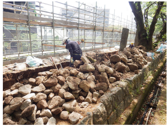
工事① 栗石の掘り起こし
