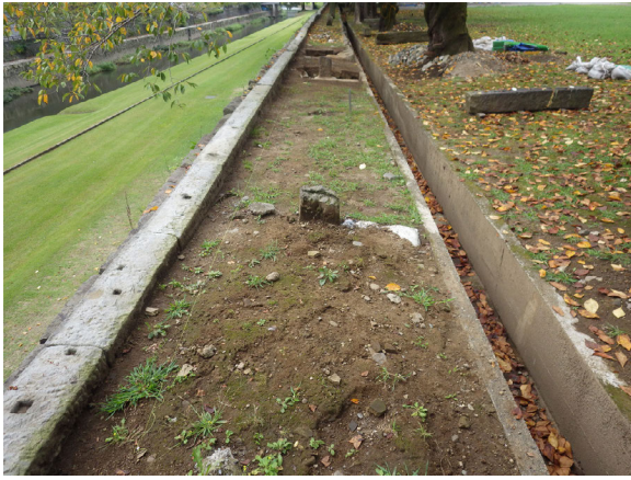
トレンチ 13 調査前状況 (東から)
