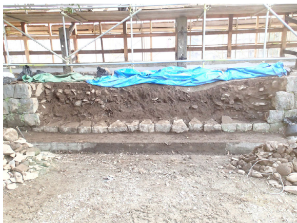
工事⑤ 解体と背面整形完了後（北から）
