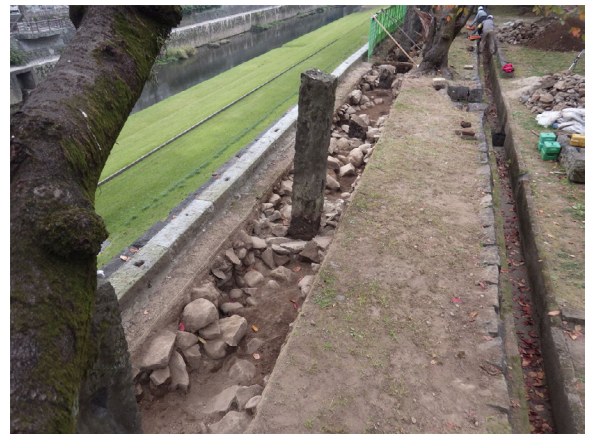
トレンチ 17 西半部完掘状況（北東から）
