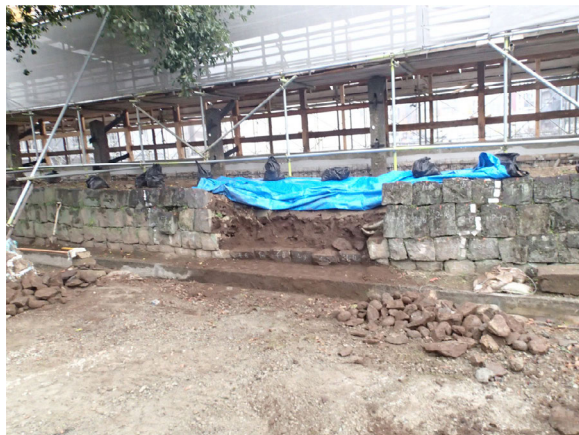
工事⑤ 崩落石材除去後（北西から）
