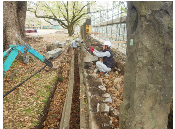
工事④ 解体
