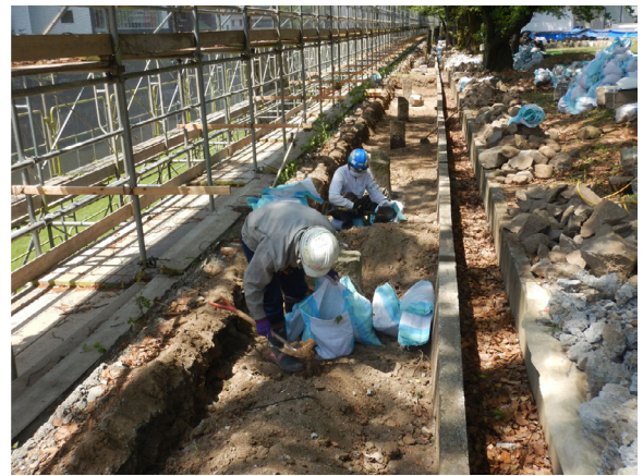
工事① 掘方最終整形
