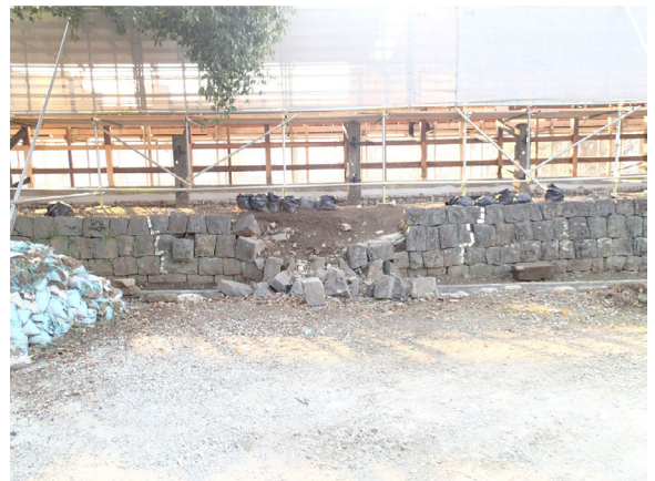
工事⑤ 施工前状況 (北から)
