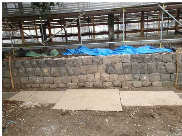
工事④ 工事完了（北から）
