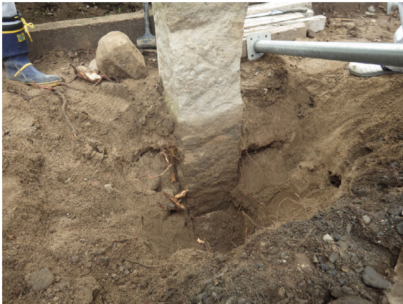
工事③ 控石柱周囲の掘削
