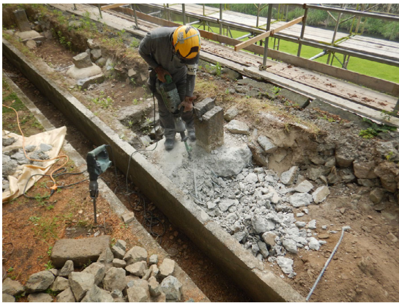
工事① 掘方整形 既存コンクリート基礎破碎
