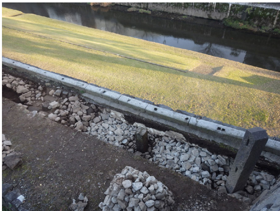
トレンチ 20 平成 24 年修理部栗石検出状況（北西から）
