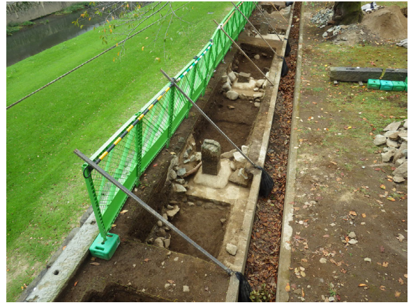
トレンチ 13 完掘状況 (東から)
