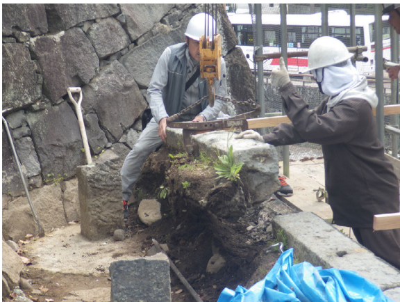
工事② 基礎石取り外し
