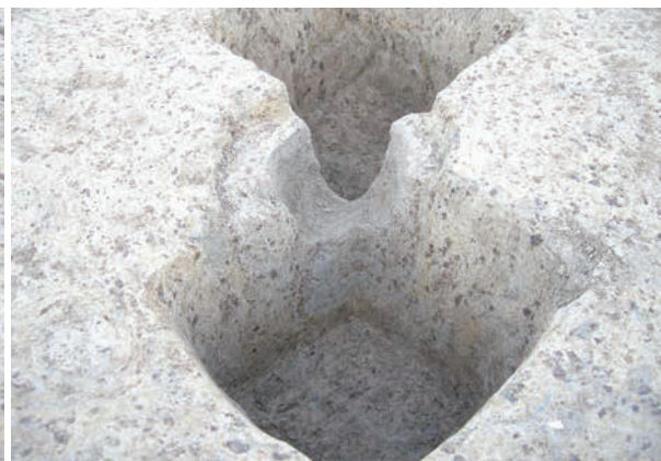
②SB3内SP132断面 (南東から)
