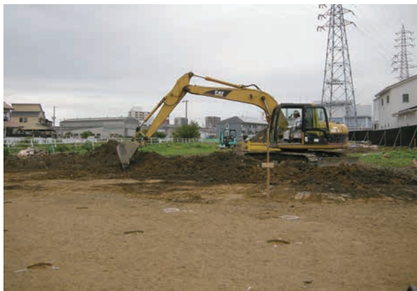
①西区 重機による表土掘削状況（西から）
