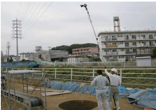
⑧ 測量のためのポール写真撮影状況 (南東から)
