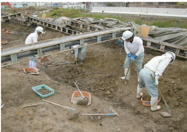
②SR 308 掘削状況（北東から）
