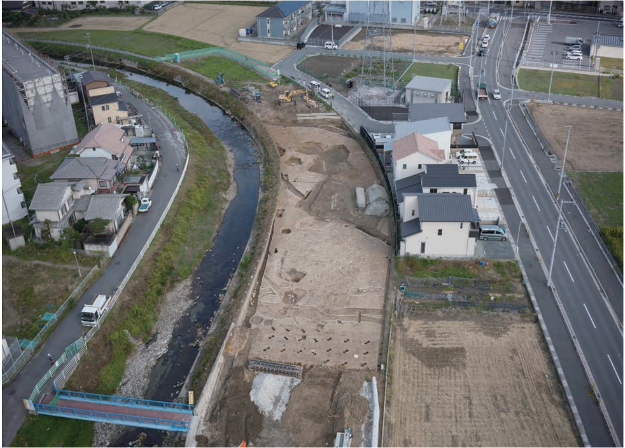
西区全景（西上空から）
