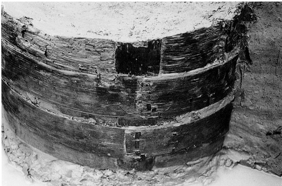
1 379井戸 井戸側細部（南から）
