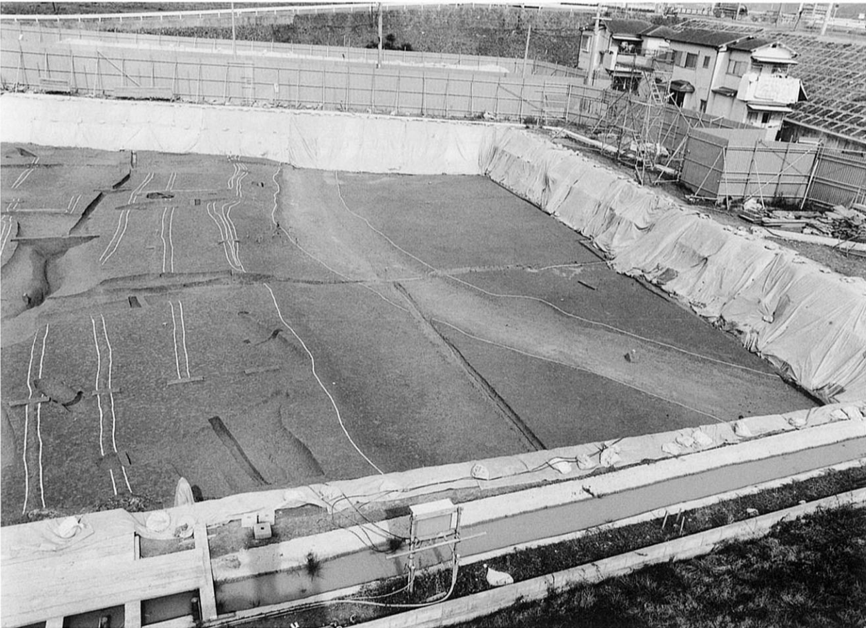
2 東半 第7面全景 (南から)
