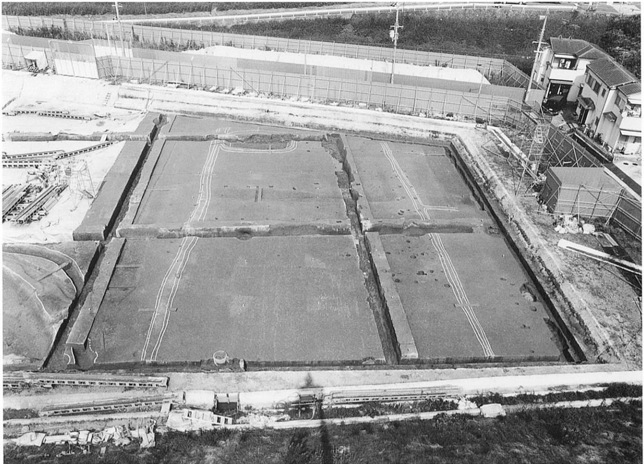
1 東半 第3面全景 (南から)
