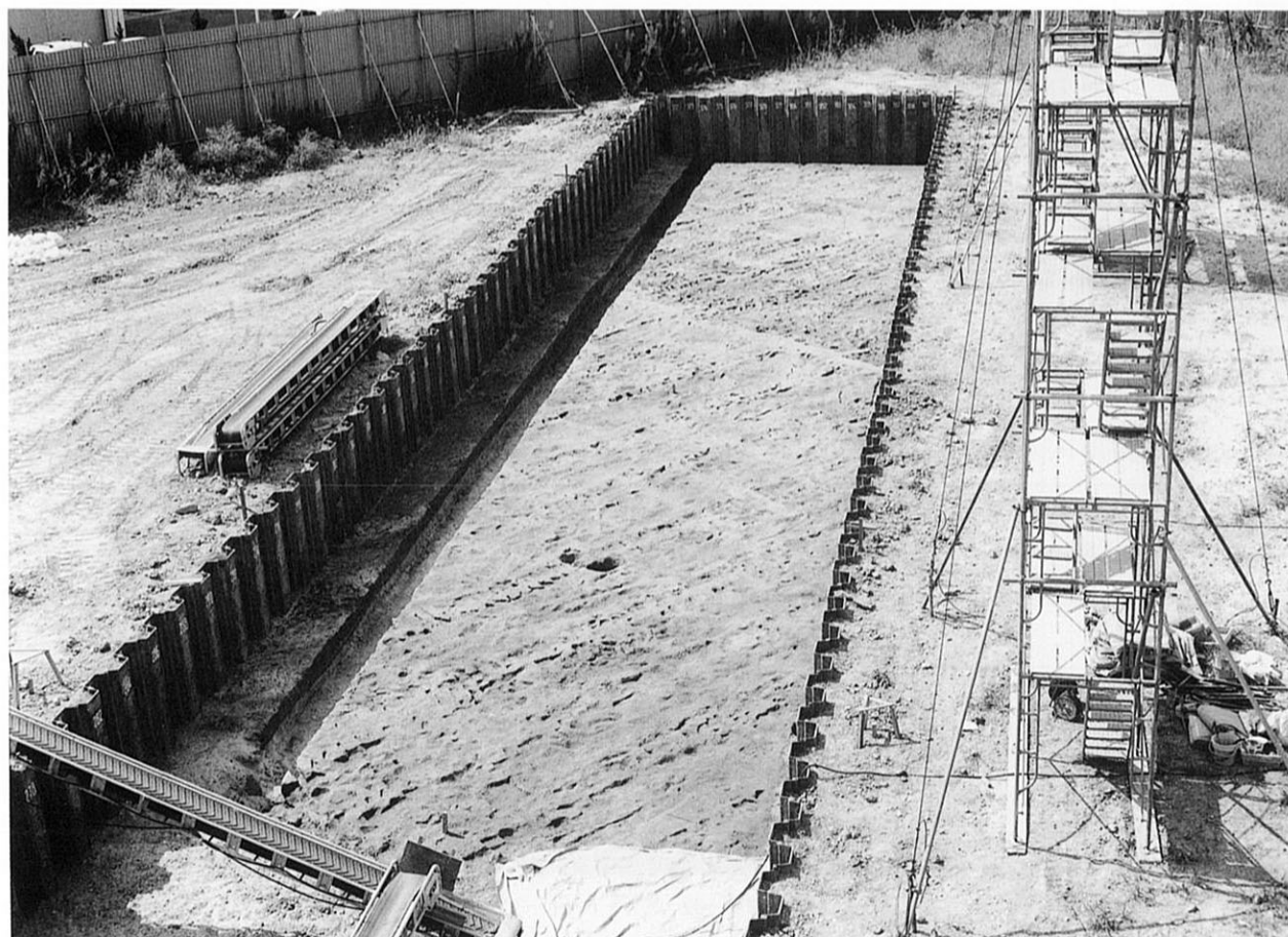
2 西半 第1面全景 (北東から)
