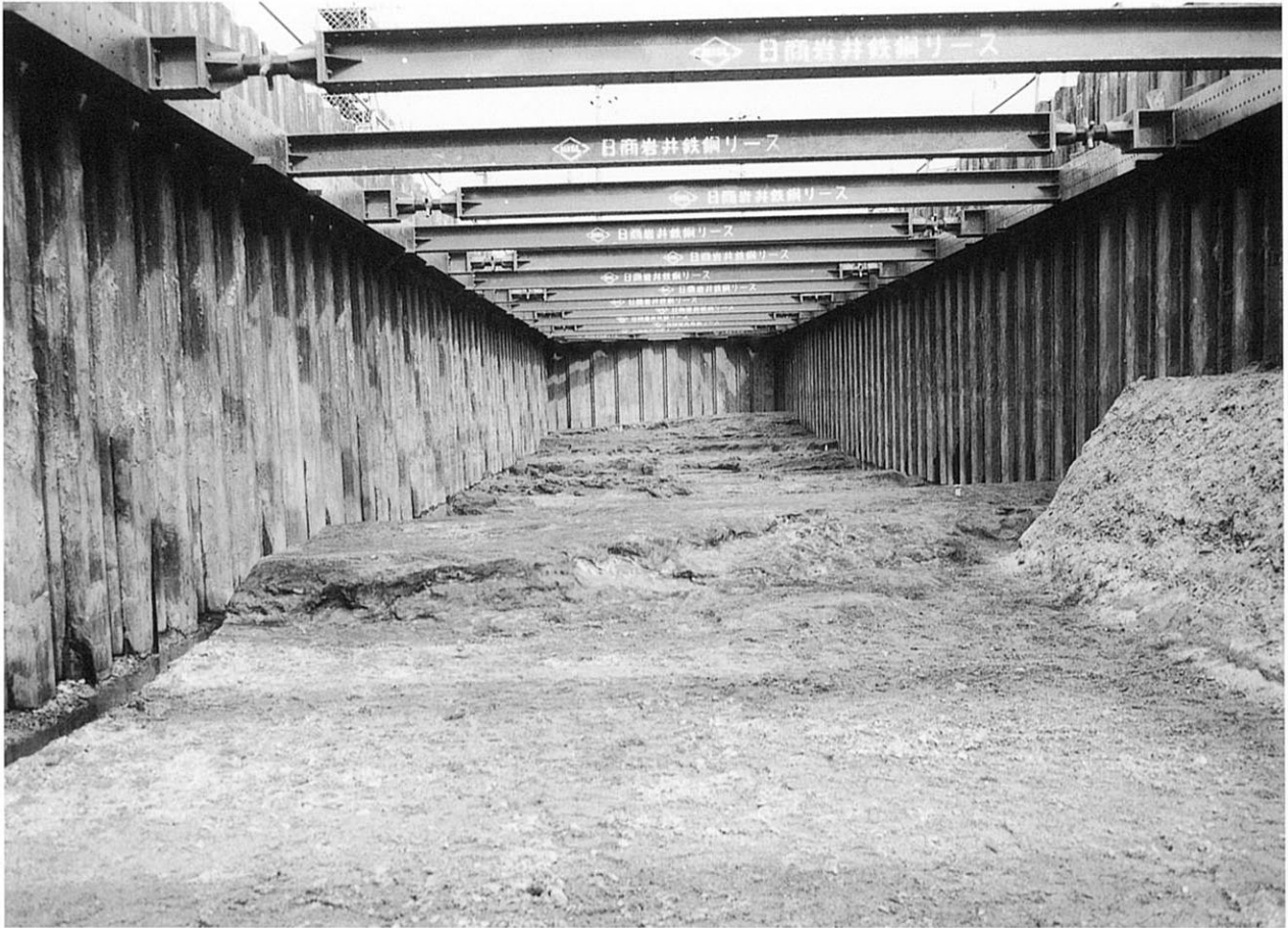
1 第3面（河床面）全景（南西から）
