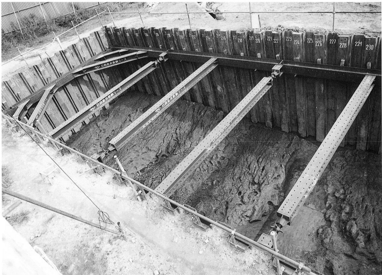
2 第3面（河床面）全景（西から）
