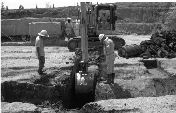
下層確認トレンチ掘削作業
