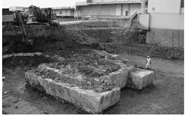
盛土除去作業
