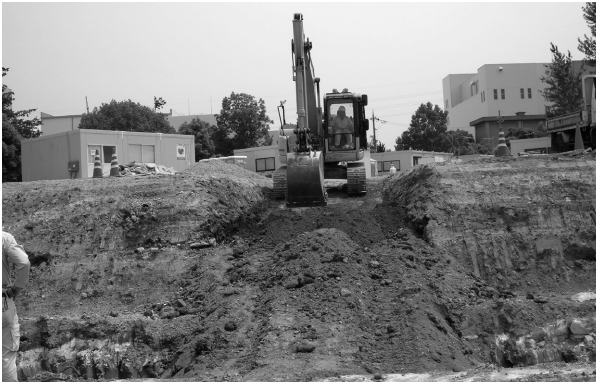
スロープ仮設作業
