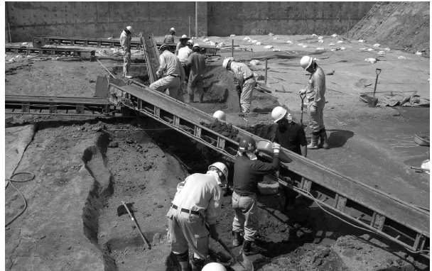
SD01掘削作業
