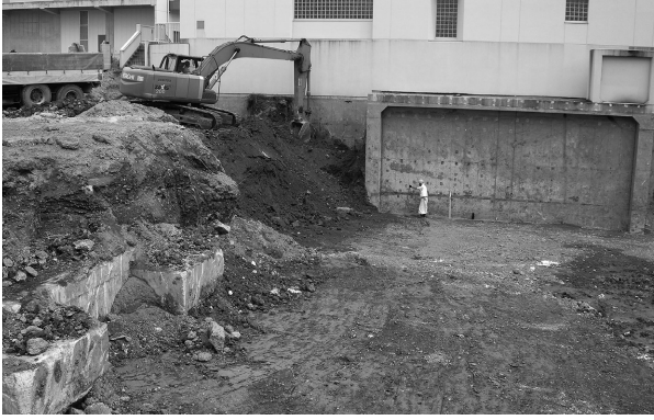
盛土除去作業
