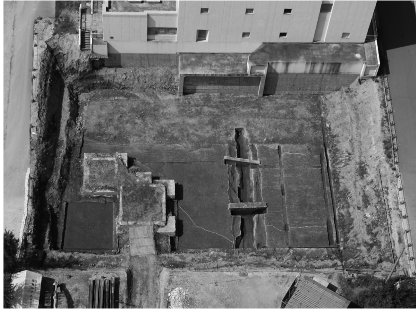
A・C区第2面全景 (南上空から)
