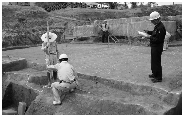
中間検査状況
