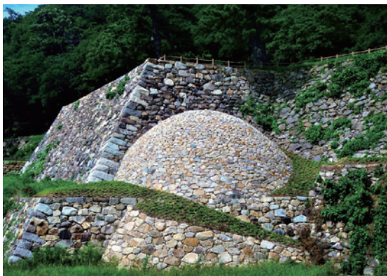
図179 鳥取城天球丸「巻石垣」(復元)
