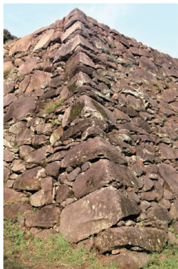
図172 肥前名護屋城 山里口石垣
