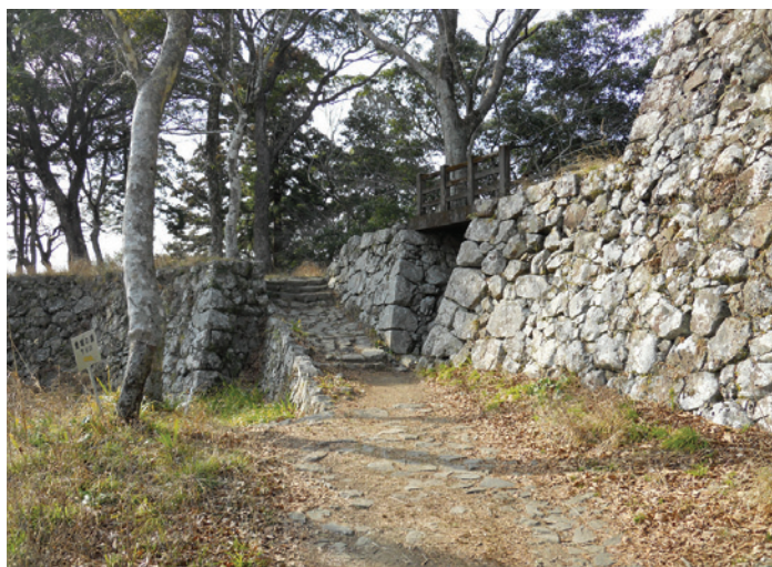
廊下橋付近 北東から
