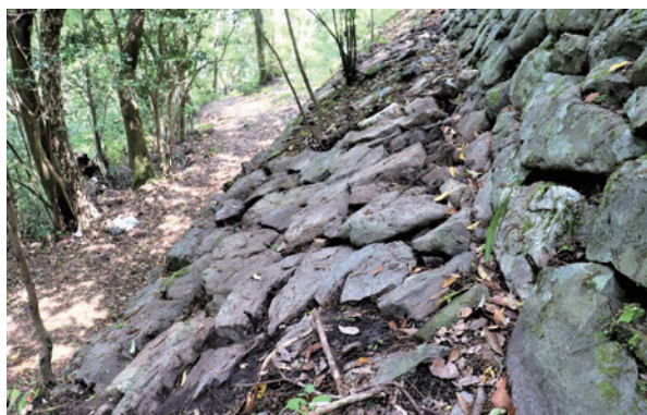
図176 雛壇状石垣 1段目天端の「小端立て」と傾斜の様子
