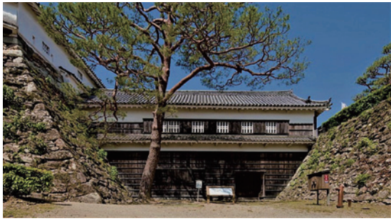
図166 高知城詰門 (下階が堀切を塞ぐ門口。上層の渡櫓を經由して右の二ノ丸から左の本丸へ入る構造)
