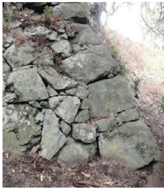
図169 二の丸二重櫓下 石垣No.324 （左下の赤いスクリーンは「ハバキ」石垣の範囲を示す）
