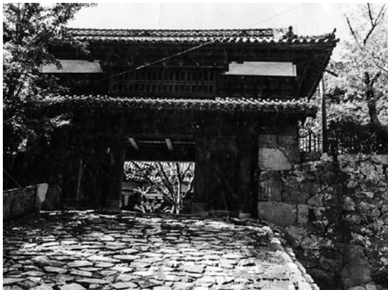
図109 修理前の櫓門(昭和30年頃)
