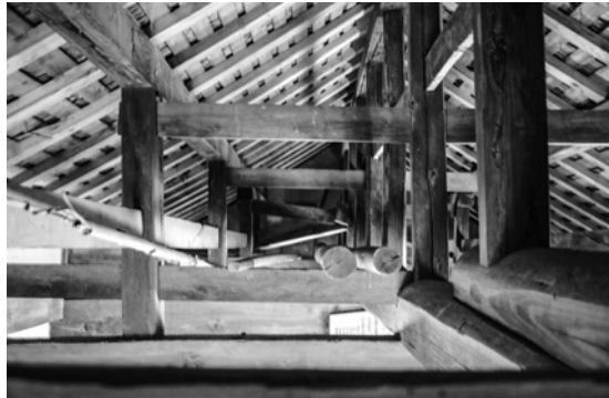
図110 櫓門内部（天井部分）
