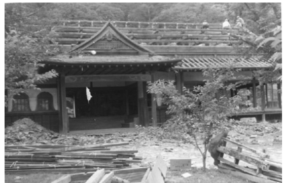
図117 三の丸御殿解体風景（昭和45年）
