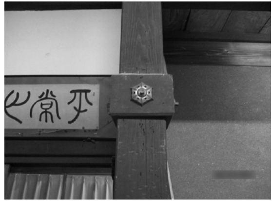
図116 住吉御殿内部に残る長押の釘隠し
