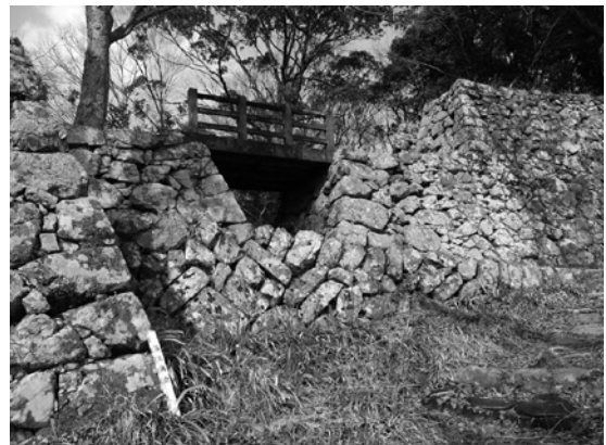
図140 廊下橋跡現況 南西より
