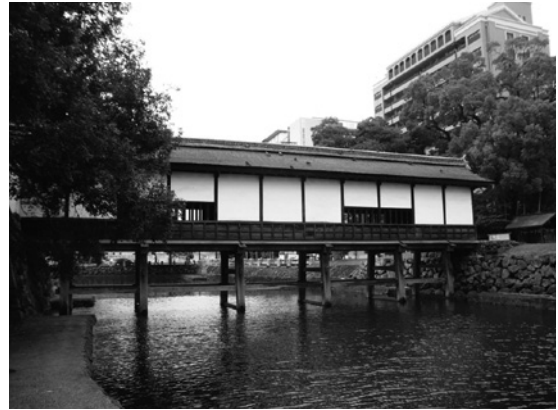
図139 復元された府内城廊下橋
