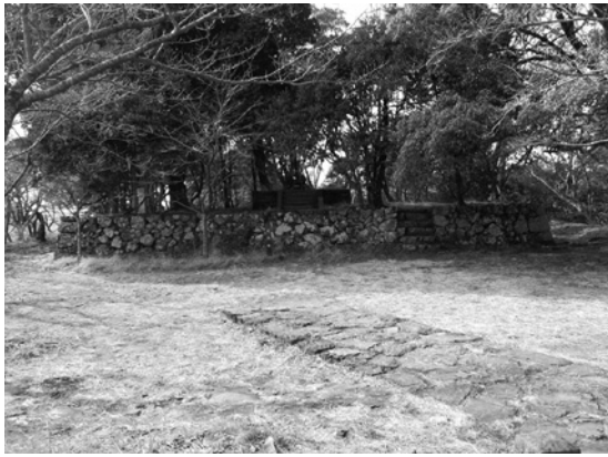
図120 天守台現況 東から
