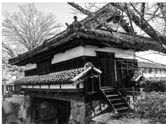
図112 櫓門裏側外観
