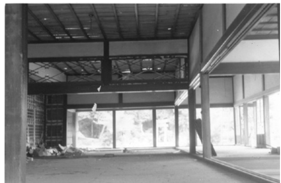
図118 解体前の御殿内部（昭和45年）
