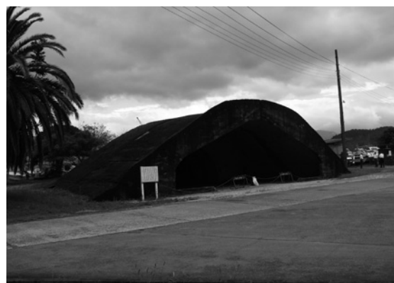
図11 佐伯海軍航空隊の掩体壕 えんたいごう (国登録有形文化財)
