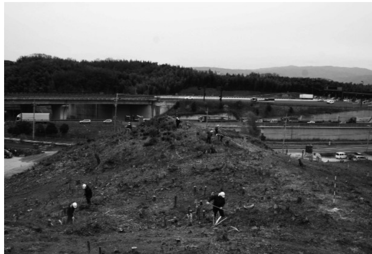
第3図 調査前作業風景
