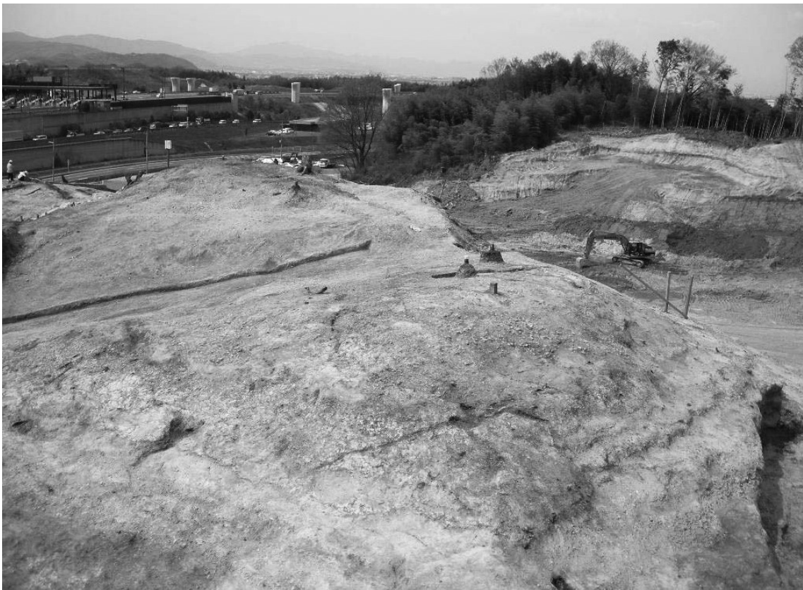
第 72 図 3・4号地点調査後全景（南東から）
