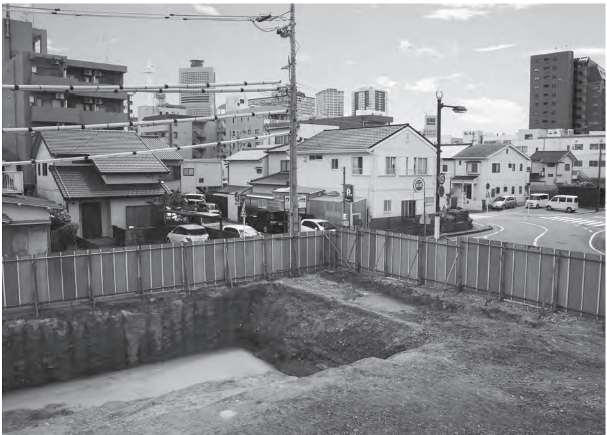
4 調査区2 完掘状況（北西から）
