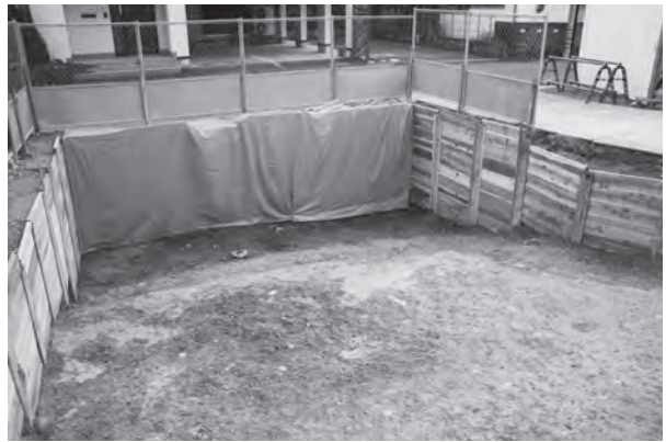
2 調査区1 完掘状況（北西から）
