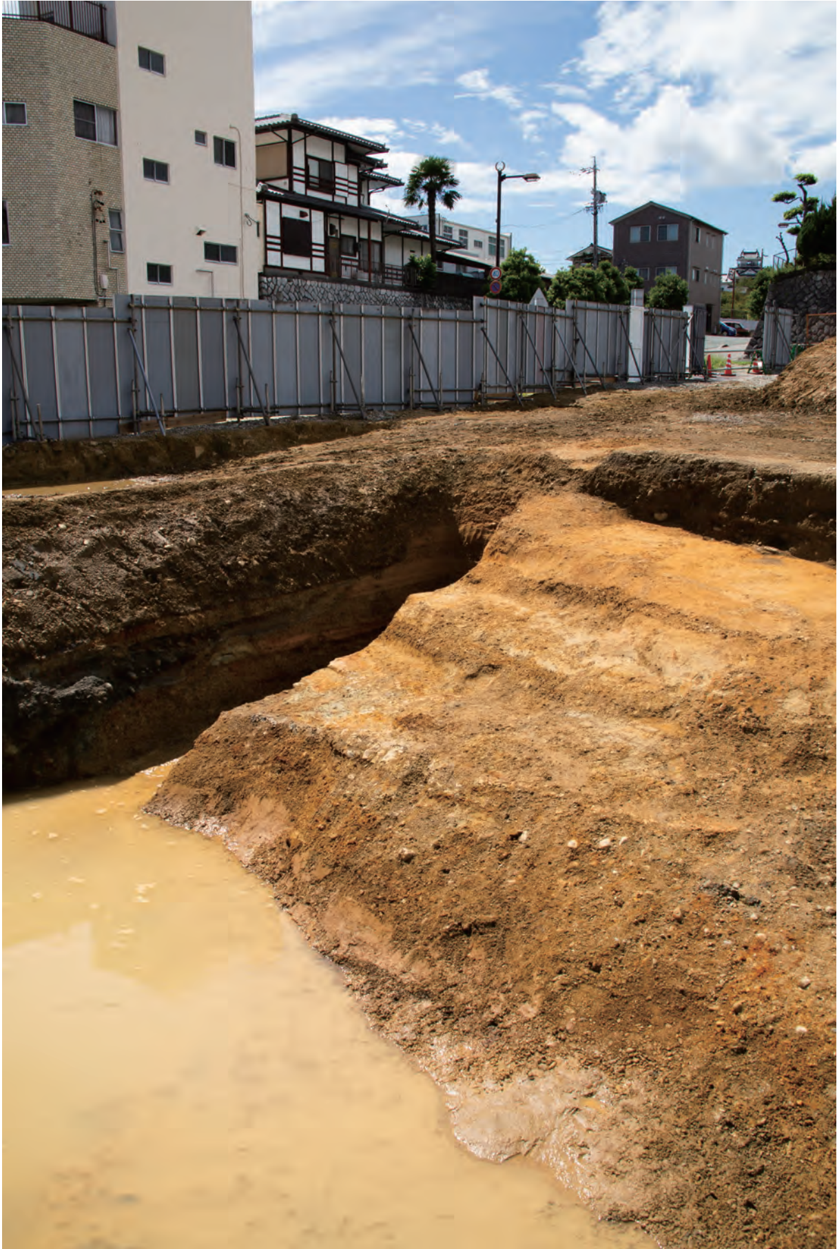
40次調査区2 全景（北東から）
