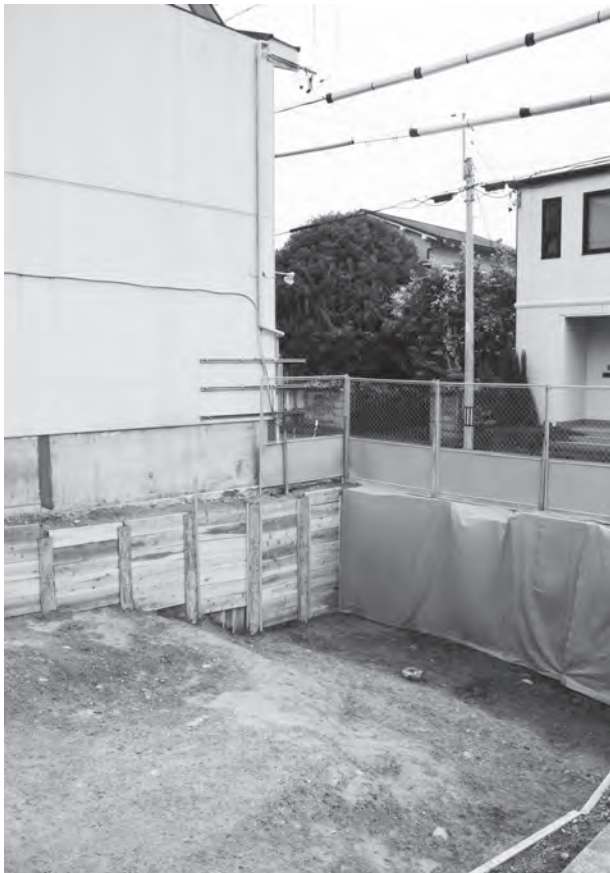
1 調査区1 完掘状況（南西から）
