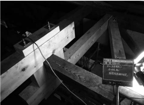
写真 4 - 60 新設陸梁取付状況
