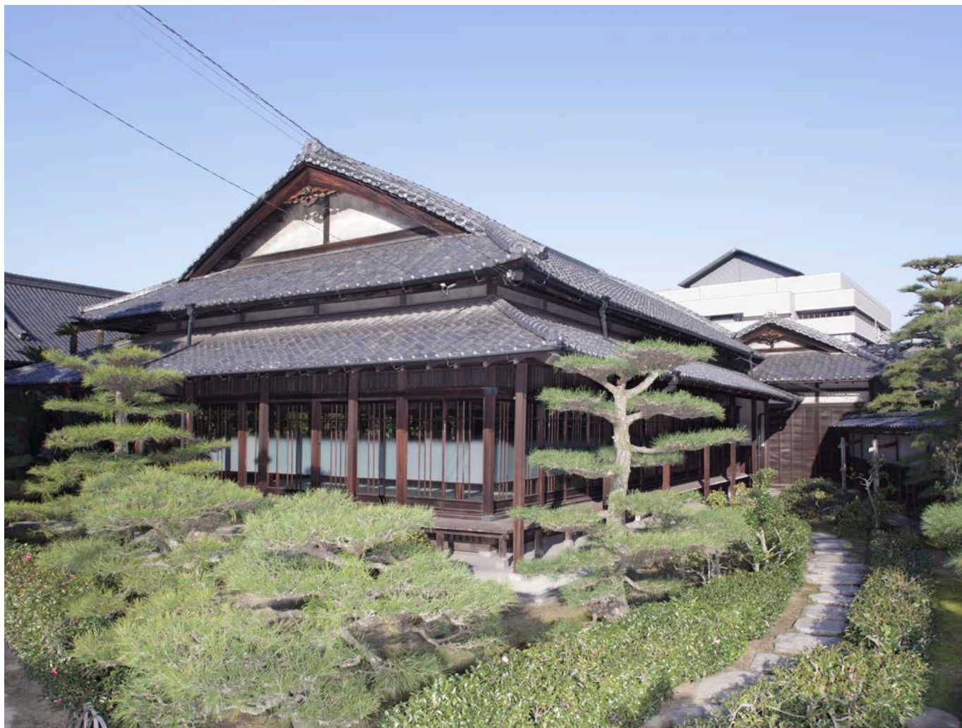
耐震補強前 蘇鉄の間外観（南西から）
