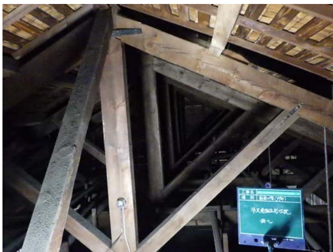
耐震補強前 小屋組み各所
