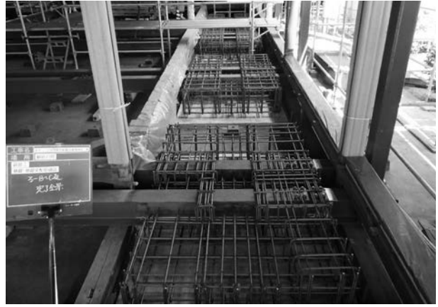
写真 4 - 47 基礎配筋完了
