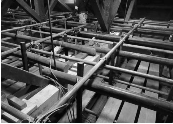
写真 4-3 室内の吊り足場
