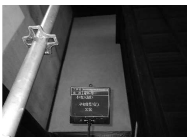
写真 4 - 106 砂漆喰塗り完了状況
