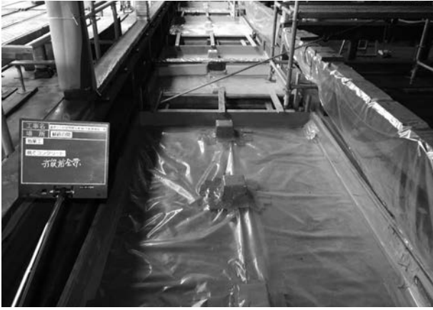
写真 4 - 43 捨てコン打設前養生状況
