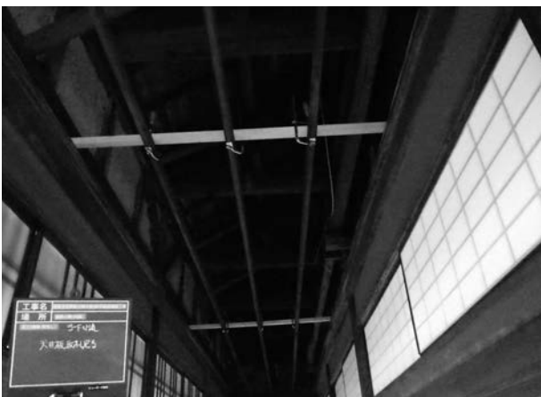
写真 4 - 29 天井板取外し状況
