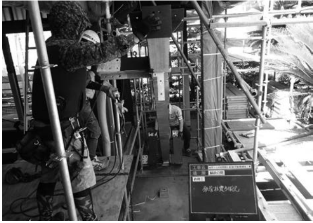
写真 4 - 67 鉄骨柱建方状況
