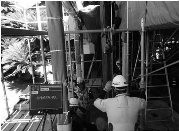
写真 4 - 68 鉄骨建方施工状況
