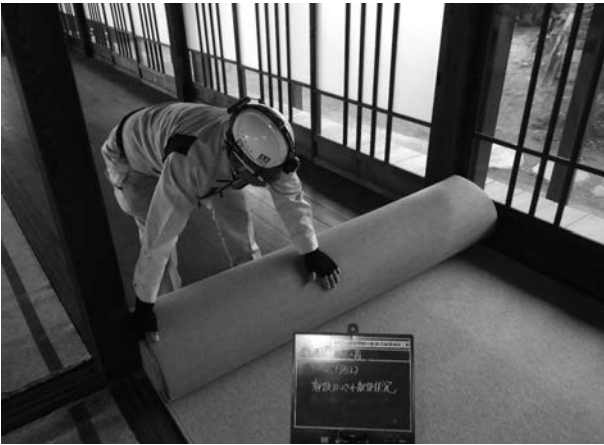
写真 4 - 108 カーペット復旧状況
