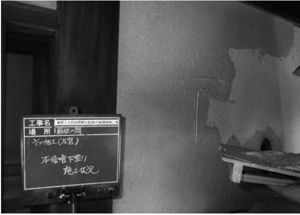
写真 4 - 107 本漆喰下塗り施工状況
