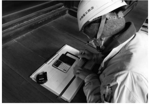
写真 4-7 大工による野帳作図
