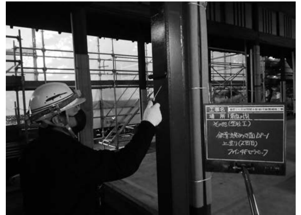
写真 4 - 73 鉄骨上塗り状況
