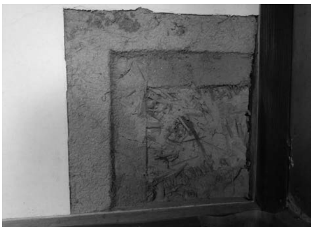
写真 4 - 101 漆喰調査状況
