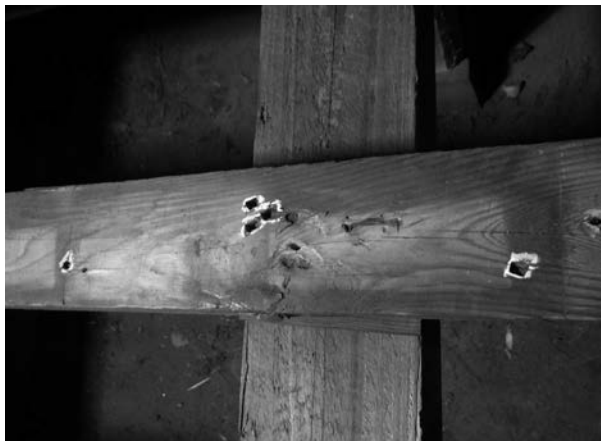
写真 2 - 35 釘穴調査の拡大
