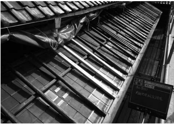
写真 4 - 75 野垂木まで復旧状況
