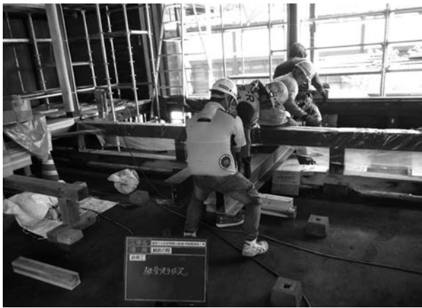
写真 4 - 69 室内の鉄骨搬入状況
