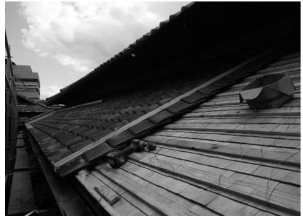
写真 4 - 88 銅線施工完了状況
