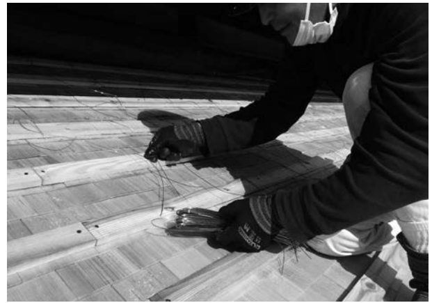
写真 4 - 87 瓦固定用銅線施工状況
