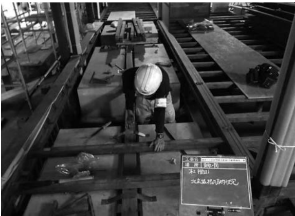
写真 4 - 92 広縁大引の固定状況
