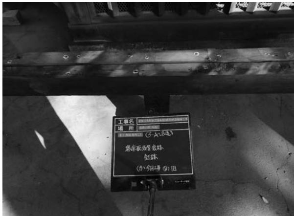
写真 2 - 34 縁大引の釘穴調査
