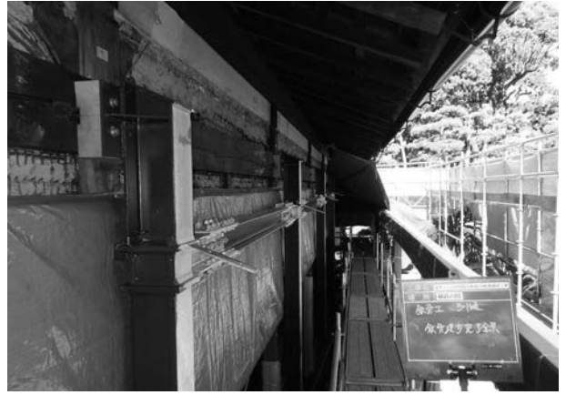
写真 4 - 71 鉄骨柱建方完了状況
