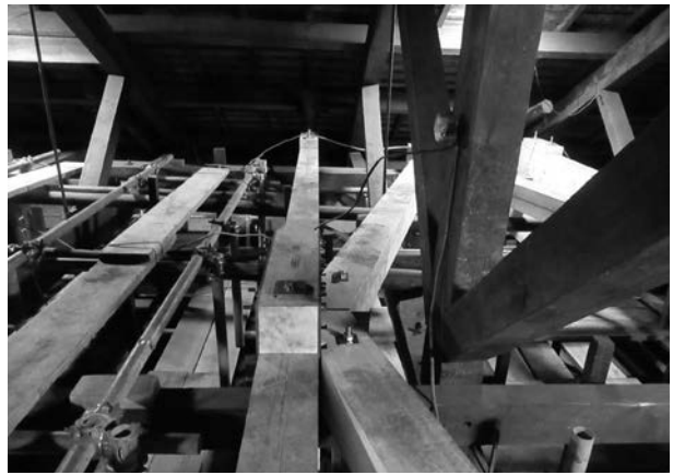
写真 4 - 63 新設陸梁設置状況
