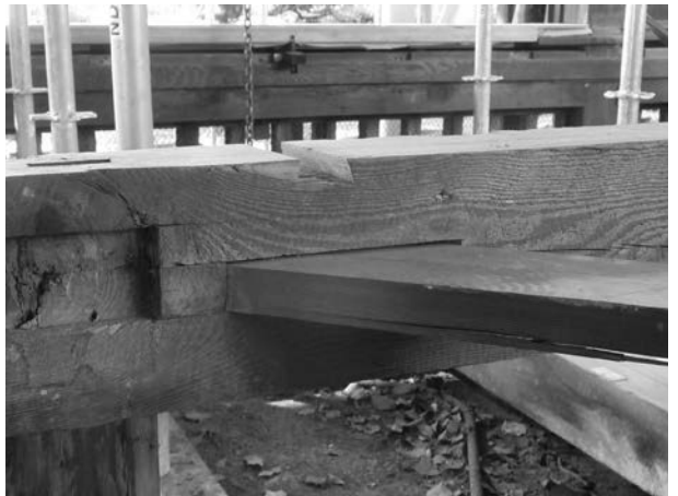
写真 2 - 31 火打設置状況近景
