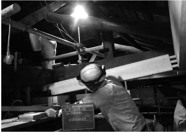
写真 4 - 51 V 3材取付状況
