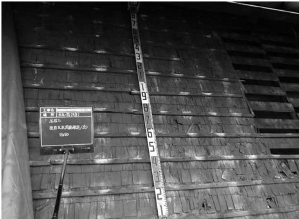
写真 4 - 20 既存の瓦棧間隔
