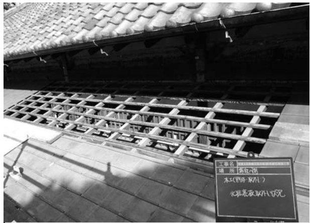
写真 4 - 25 化粧裏板取外し状況
