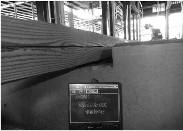
写真 4 - 91 広縁大引復旧状況
