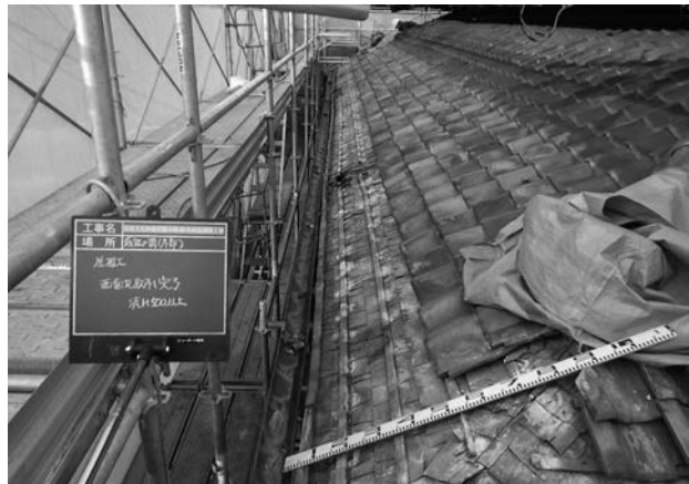
写真 4-9 西面庇瓦取外し状況
