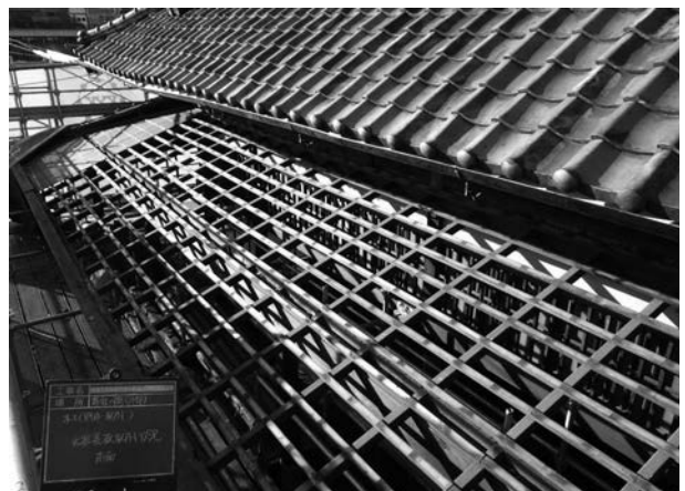
写真 4 - 26 化粧裏板取外し完了状況
