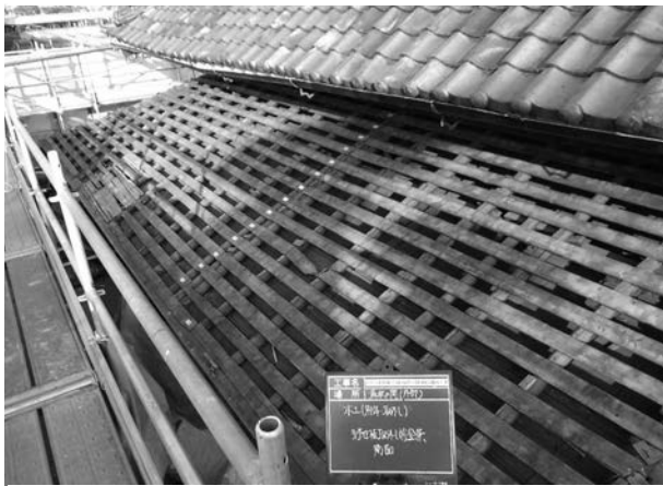
写真 4 - 21 野地板撤去前状況
