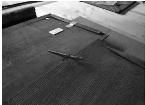
写真 4 - 32 天井板固定方法
