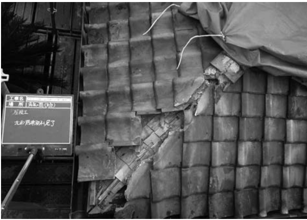
写真 4 - 11 北西庇隅棟瓦取外し状況
