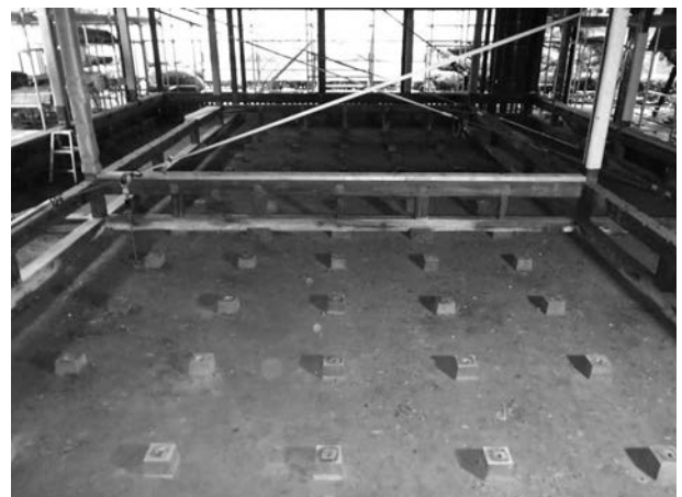
写真 4 - 42 床束取外し状況
