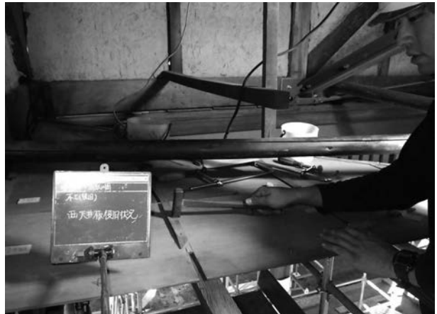
写真 4 - 64 天井板復旧状況
