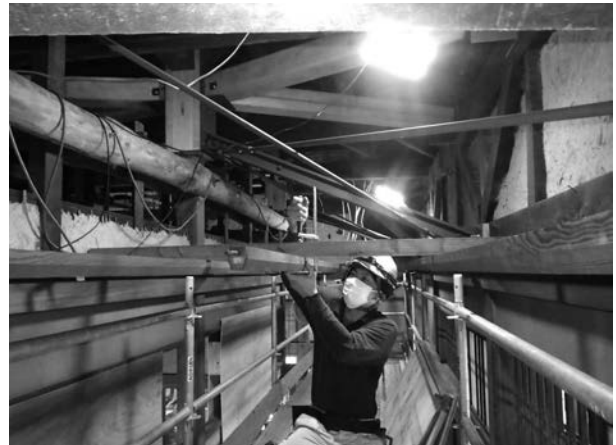
写真 4 - 65 天井竿縁復旧状況
