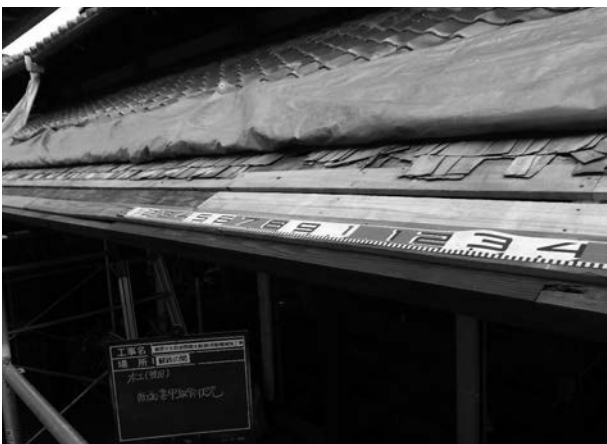
写真 4 - 77 裏甲取替状況
