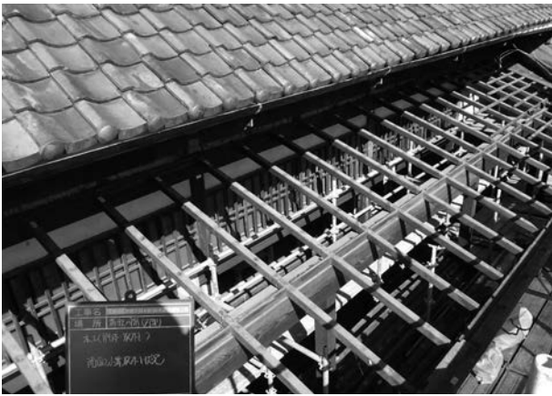
写真 4 - 27 小舞取外し状況
