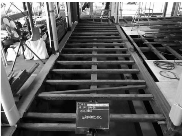
写真 4 - 94 床組復旧完了状況
