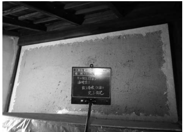
写真 4 - 104 散り漆喰完了状況
