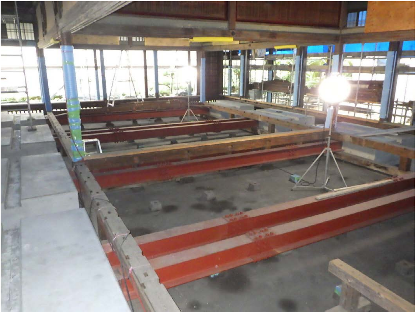
床下の補強状況（南東から）
