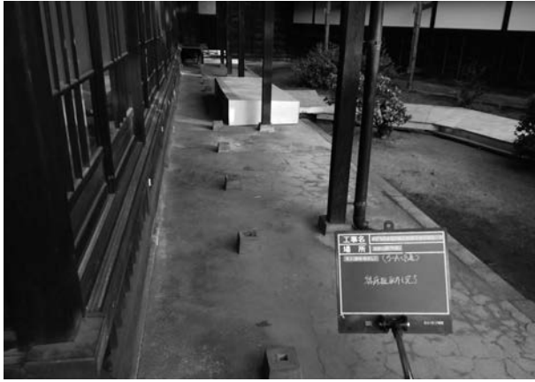
写真 4 - 35 縁床組取外し状況
