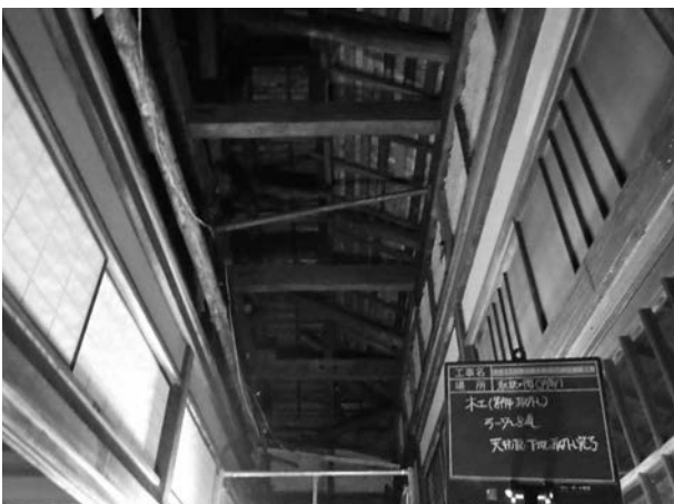
写真 4 - 30 天井板・下地取外し状況
