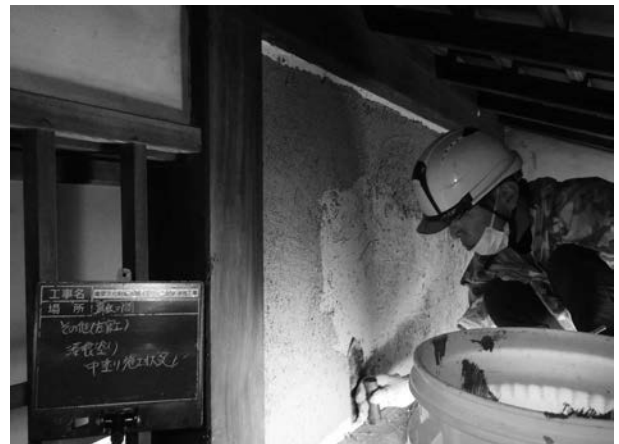
写真 4 - 105 中塗り施工状況
