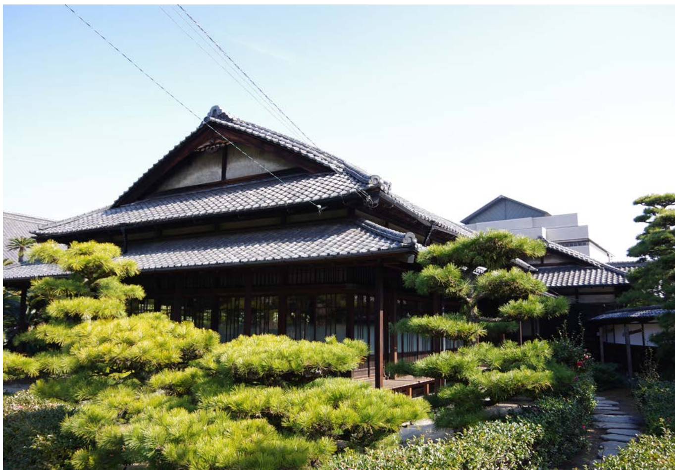
耐震補強後 蘇鉄の間外観（南西から）
