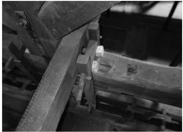
写真 4 - 112 鴨居高調整状況②
