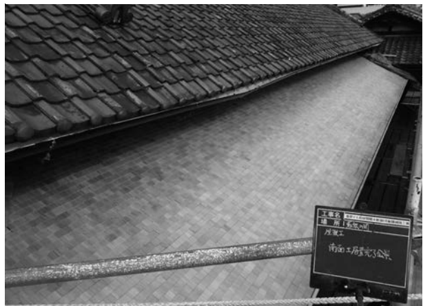
写真 4 - 81 南面土居葺き完了状況
