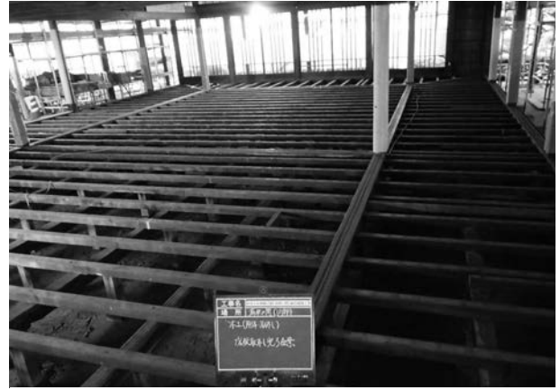
写真 4 - 39 床板取外し完了
