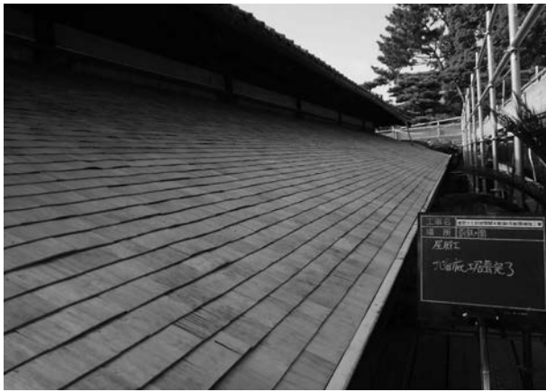
写真 4 - 83 北面土居葺き完了状況
