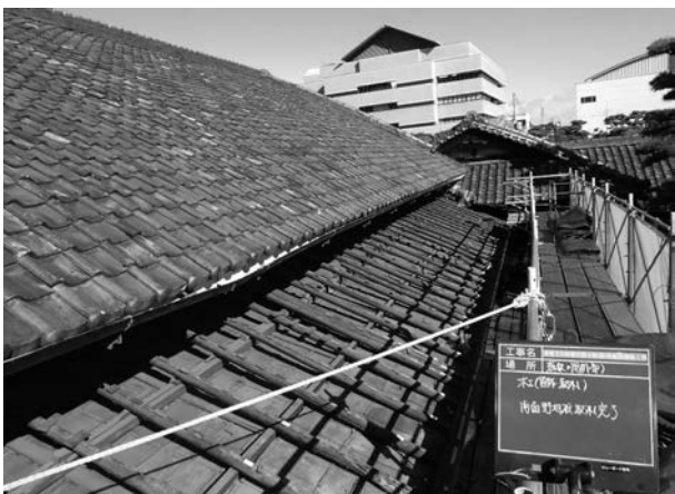
写真 4 - 22 野地板取外し状況
