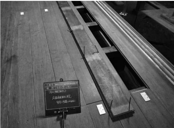
写真 4 - 36 床板取外し状況近景
