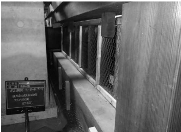
写真 4 - 100 縁下格子復旧状況
