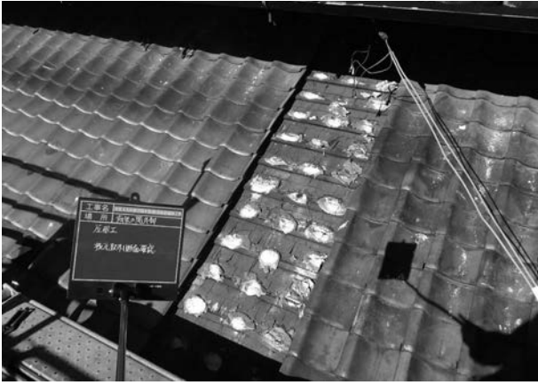
写真 2-1 瓦下地検出状況
