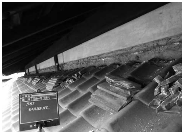
写真 4 - 17 熨斗瓦取外し状況
