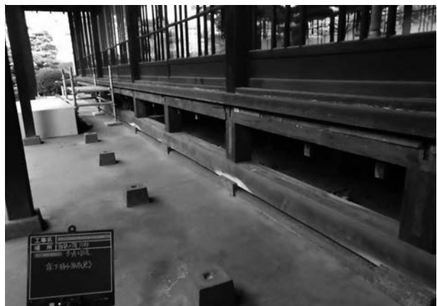
写真 4 - 34 床下格子取外し状況
