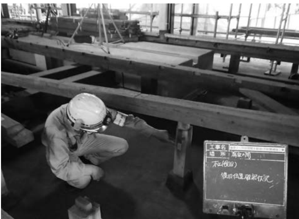
写真 4 - 93 床束復旧状況
