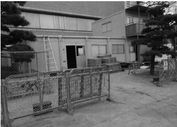
写真 4-5 古材等保管庫外観
