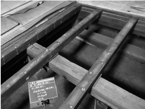
写真 2 - 33 内部根太の釘穴調査
