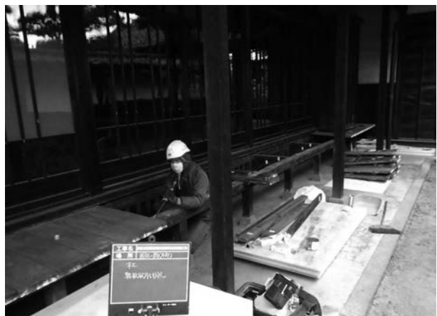
写真 4 - 33 縁板取外し状況
