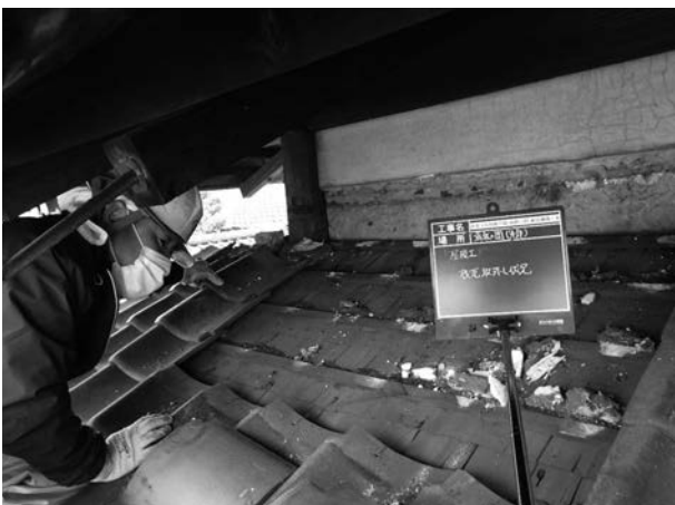
写真 4 - 14 棧瓦取外し状況
