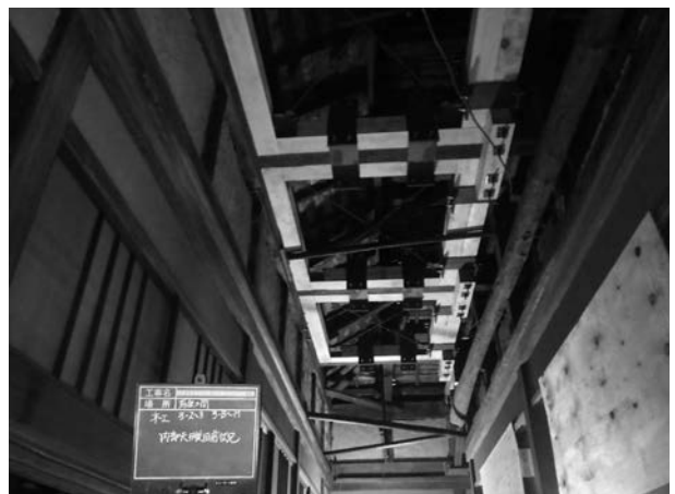
写真 4 - 58 天井裏ブレース配置状況
