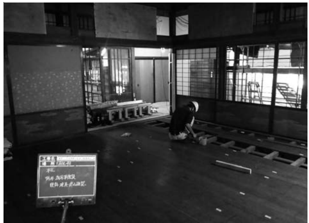
写真 4 - 96 既存建具の建込確認状況
