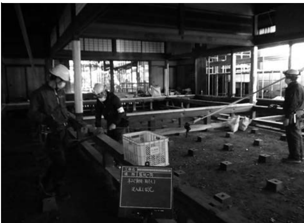
写真 4 - 109 柱建入直し状況
