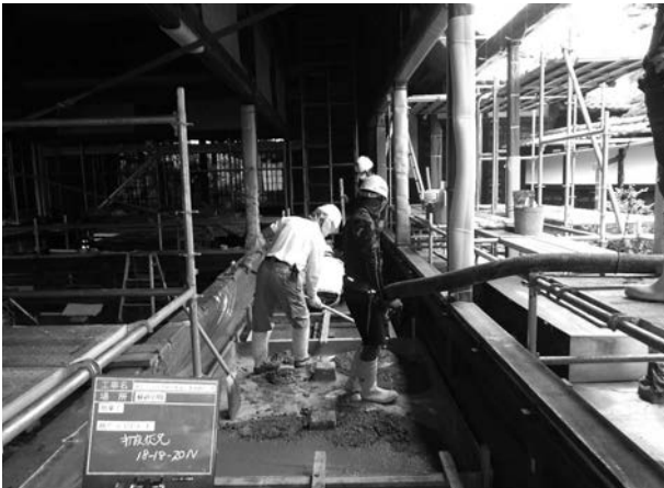
写真 4 - 44 捨てコン打設状況
