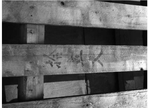
写真 2 - 24 野地板印字④
