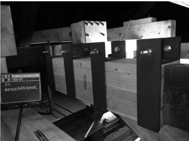
写真 4 - 62 既存陸梁補強状況
