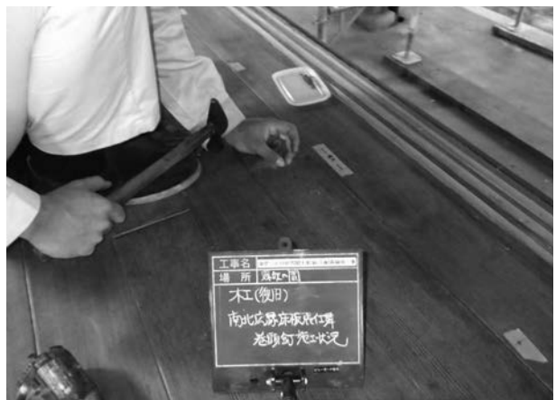
写真 4 - 97 広縁床板張仕舞 巻頭釘施工状況
