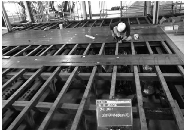
写真 4 - 95 広間床板復旧状況
