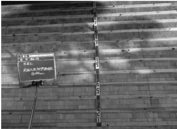
写真 4 - 84 瓦棧復旧状況
