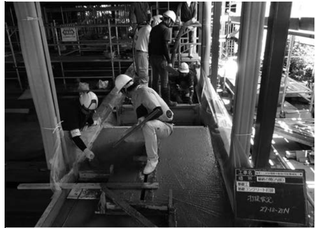
写真 4 - 48 基礎コンクリート打設状況
