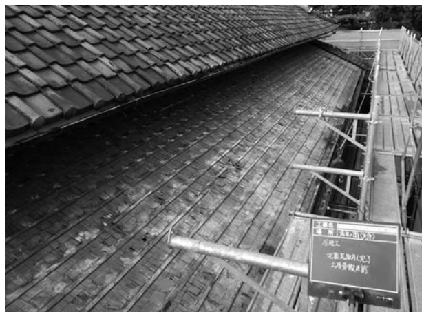
写真 4 - 18 瓦取外し完了状況
