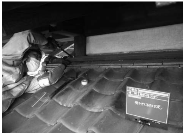
写真 4 - 16 熨斗押え取外し状況
