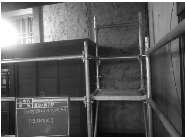
写真 4 - 102 中塗撤去完了状況
