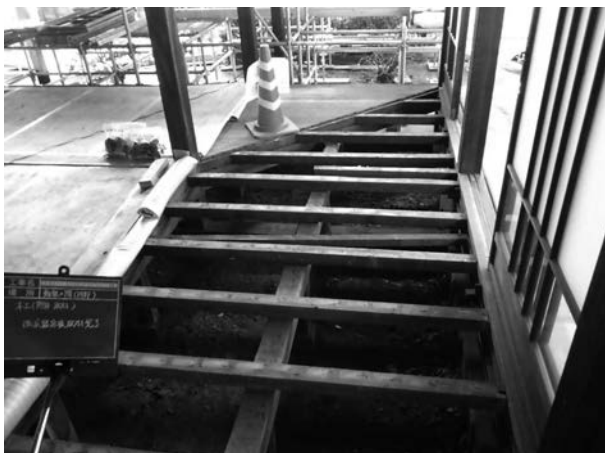
写真 4 - 38 床板取外し状況
