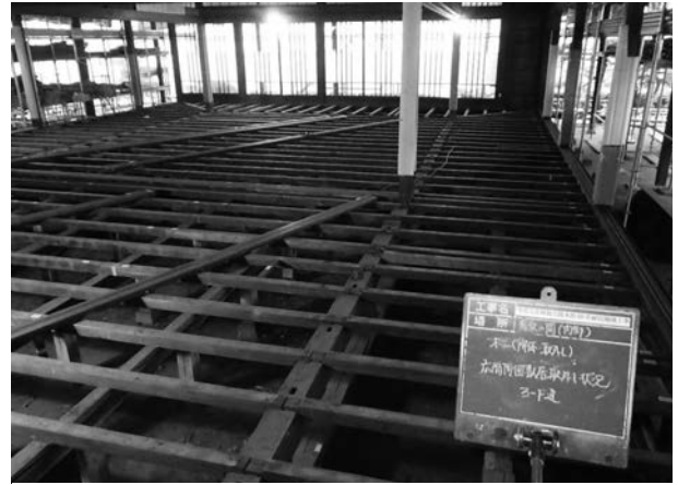
写真 4 - 40 広間敷居取外し状況
