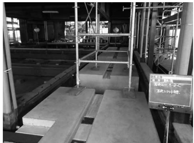
写真 4 - 50 基礎コンクリート打設完了
