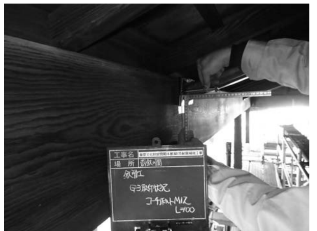
写真 4 - 74 コーチボルト取付状況
