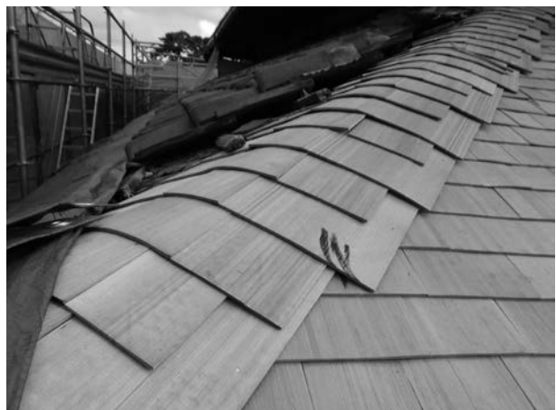
写真 4 - 82 隅の土居葺き状況
