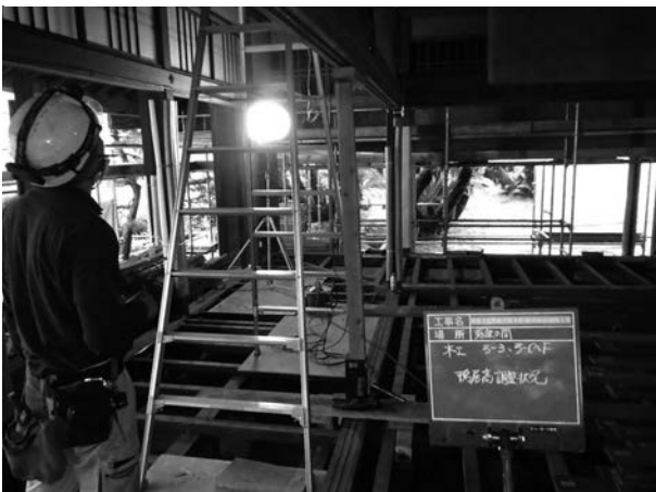
写真 4 - 110 鴨居高調整状況
