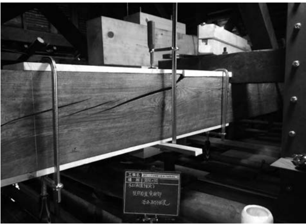
写真 4 - 61 既存陸梁のワレと補強開始状況
