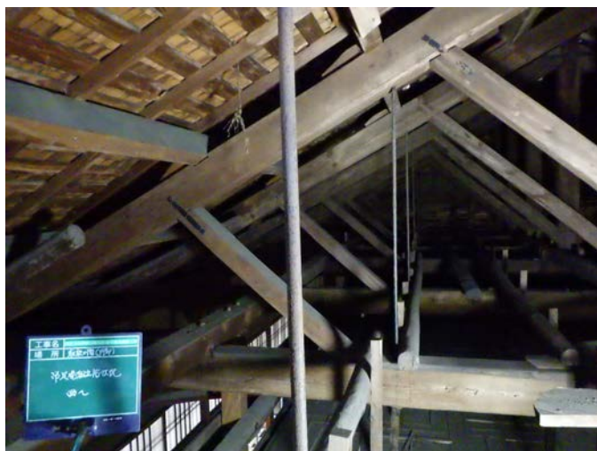
耐震補強前 小屋組み各所
