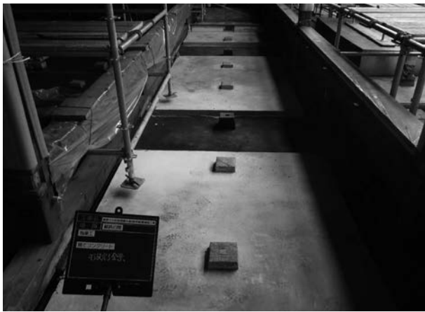
写真 4 - 45 捨てコン打設完了
