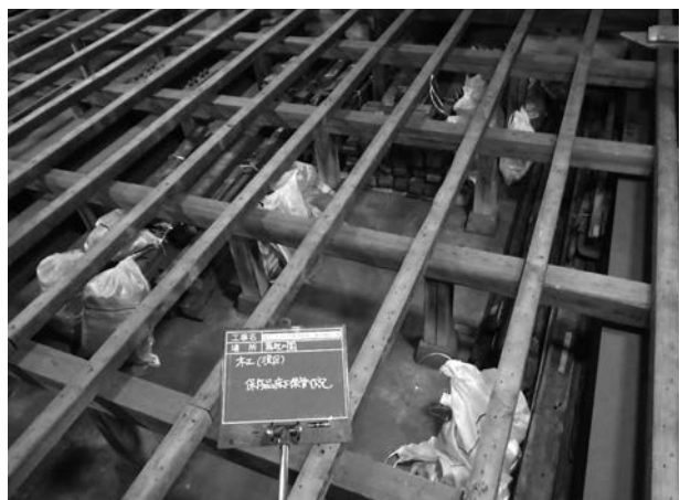
写真 4 - 114 保存部材床下保管状況
