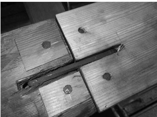
写真 4 - 78 取替裏甲 (右) 復旧状況近景
