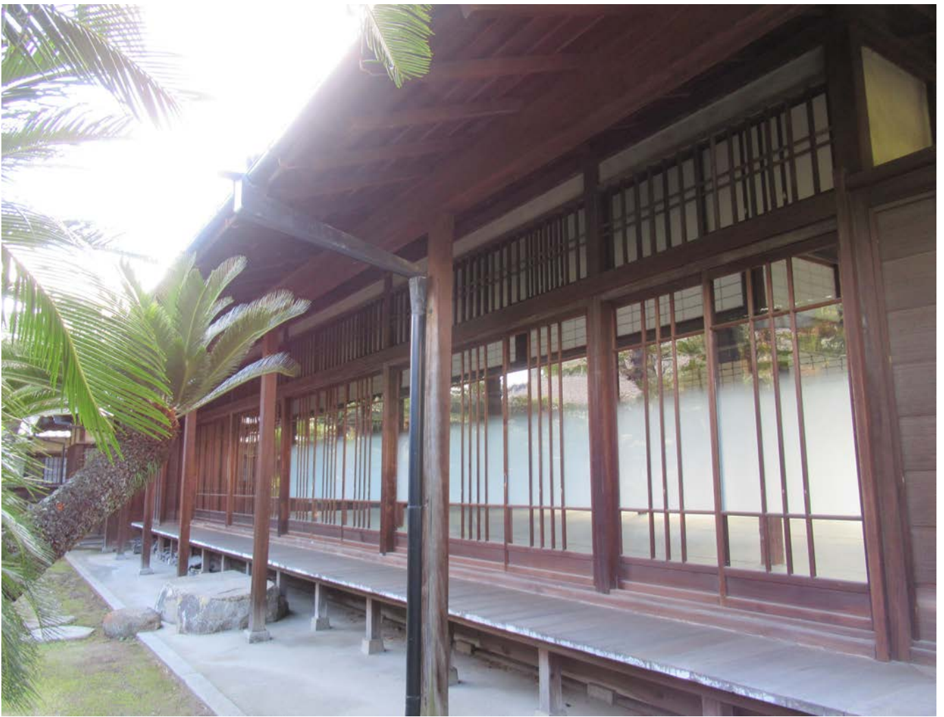
耐震補強前 蘇鉄の間北面外観（北西から）
