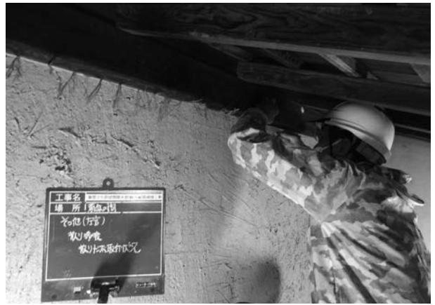
写真 4 - 103 散り漆喰 散りトンボ取付状況
