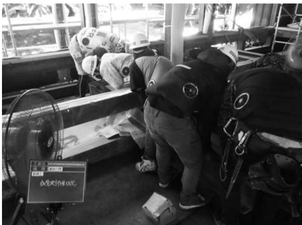
写真 4 - 70 室内の鉄骨建方状況
