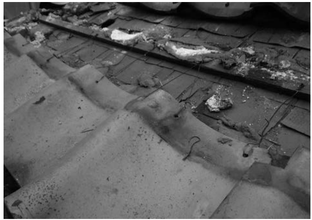
写真 4 - 15 銅線による棧瓦の固定状況
