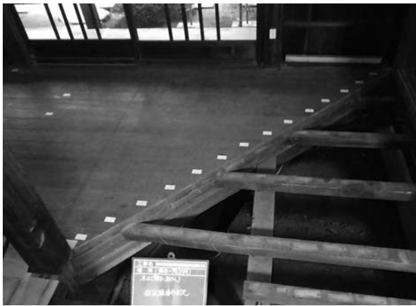
写真 4 - 37 床板番付状況
