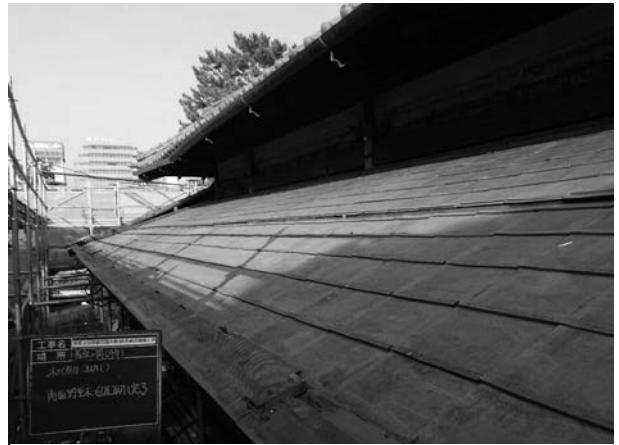
写真 4 - 24 野垂木・母屋取外し状況
