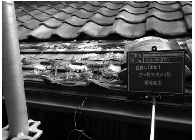
写真 4-10 西面庇軒先解体状況
