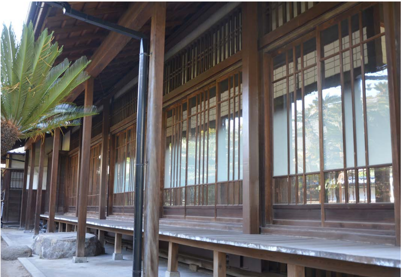
耐震補強後 蘇鉄の間北面外観（北西から）
