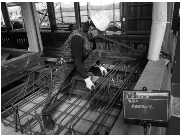
写真 4 - 46 基礎鉄筋配筋状況
