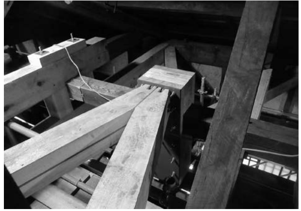
写真 4 - 55 V 4ブレース設置状況
