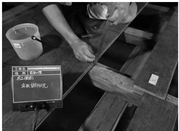
写真 4 - 98 床板留付状況
