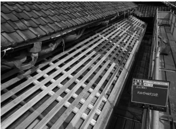
写真 4 - 76 野地板復旧完了状況
