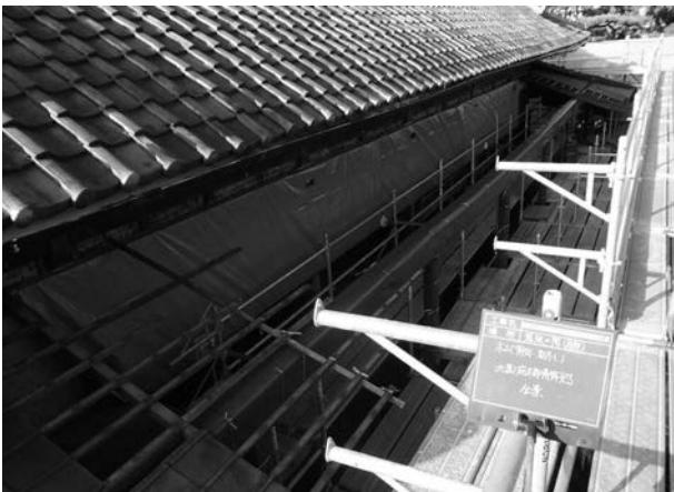
写真 4 - 28 鹿木部解体完了状況
