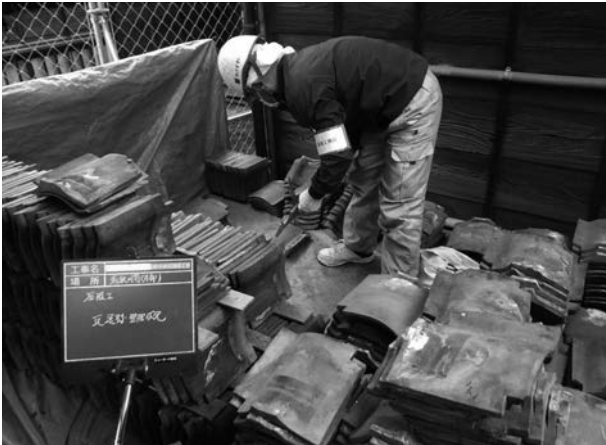
写真 2-2 打音による瓦選別状況
