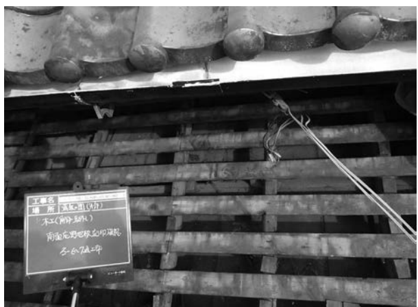
写真 2 - 20 野地板の印字
