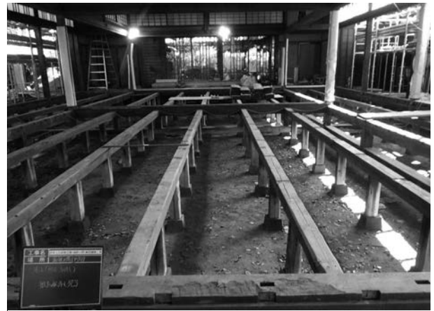
写真 4 - 41 床根太取外し状況
