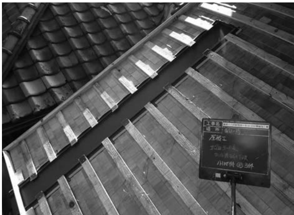
写真 4 - 85 樋下の捨て板施工状況
