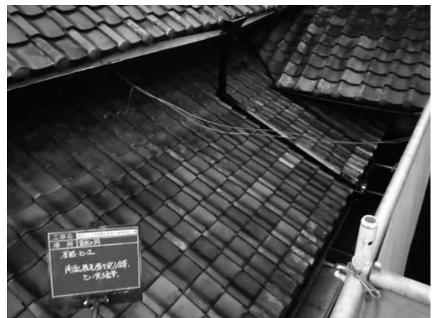
写真 4 - 90 復旧完了状況
