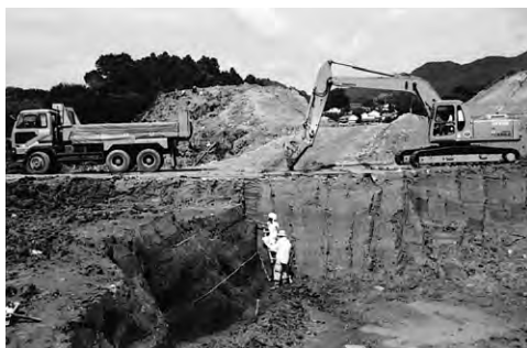
Fig. 20 池底の重機掘削
