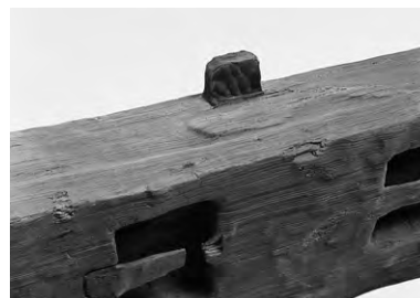
Fig. 217 90材に残る雇いのダボ
