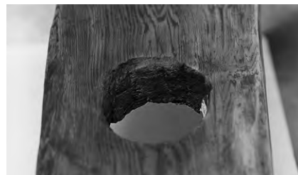
Fig. 213 48材 北端の丸ホゾ穴に残るノミ痕
