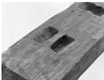
Fig. 216 92材のエツリ穴に見えるノミ痕
