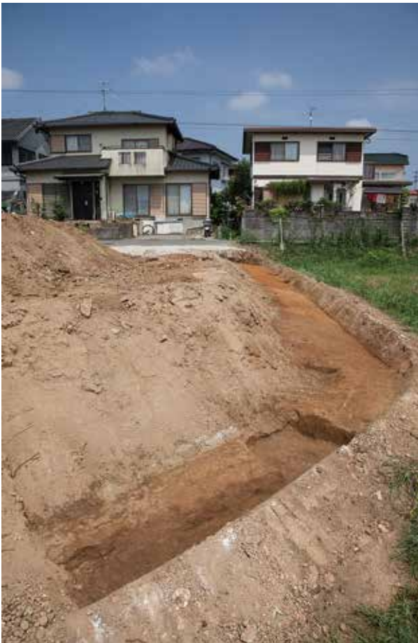
阿恵茶屋遺跡確認調査 (南東から)
