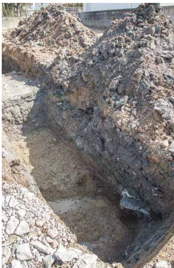
専用住宅確認調査 伝路側溝 (北西から)
