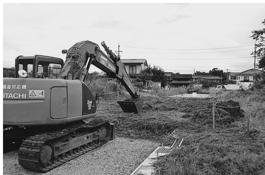
1次面重機表土除去作業
