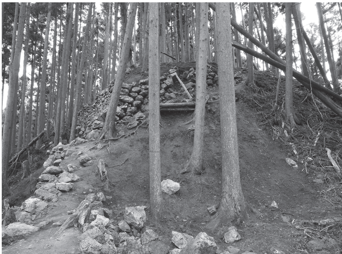
2 郭5西面石垣・郭6石塁（西から）
