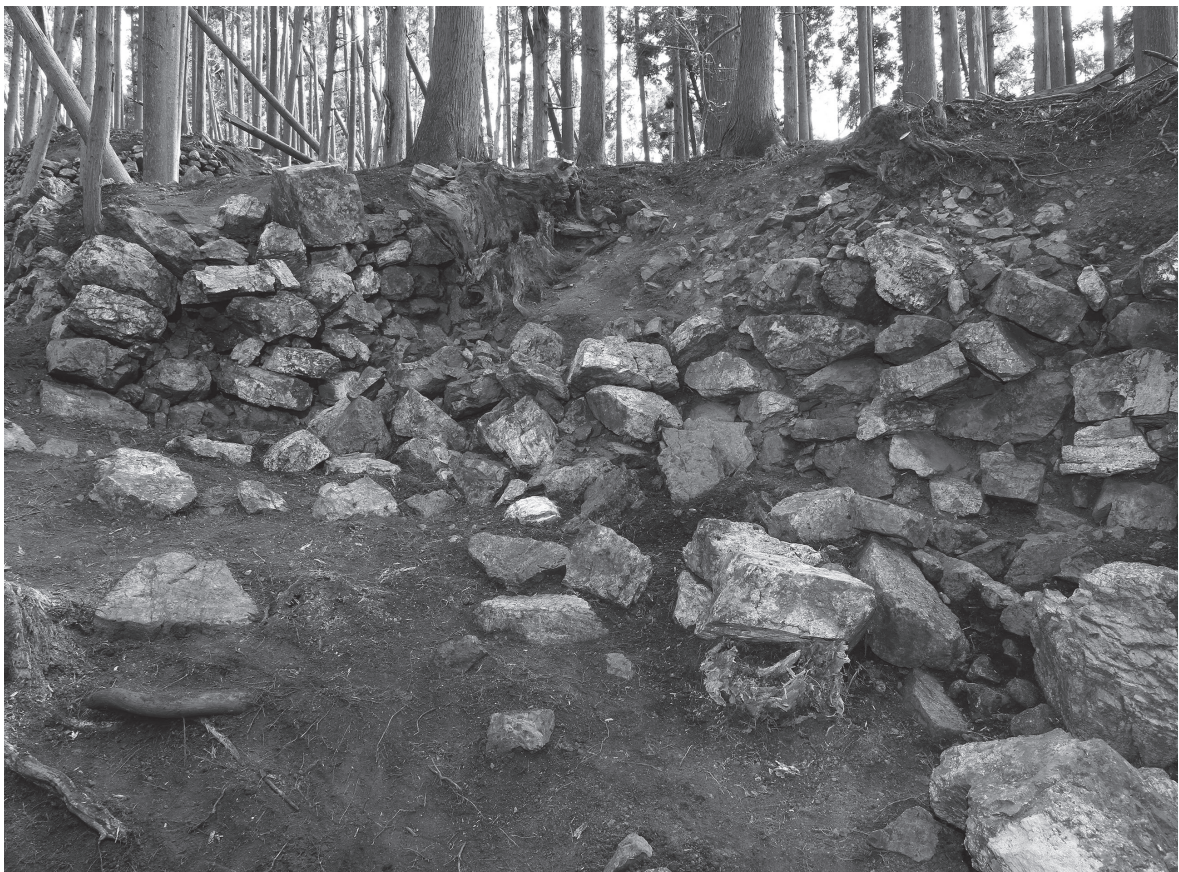
2 郭6北面石垣折れ部分（北西から）
