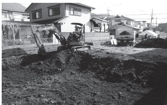
図3 機械掘削状況（第9次）（北西から）
