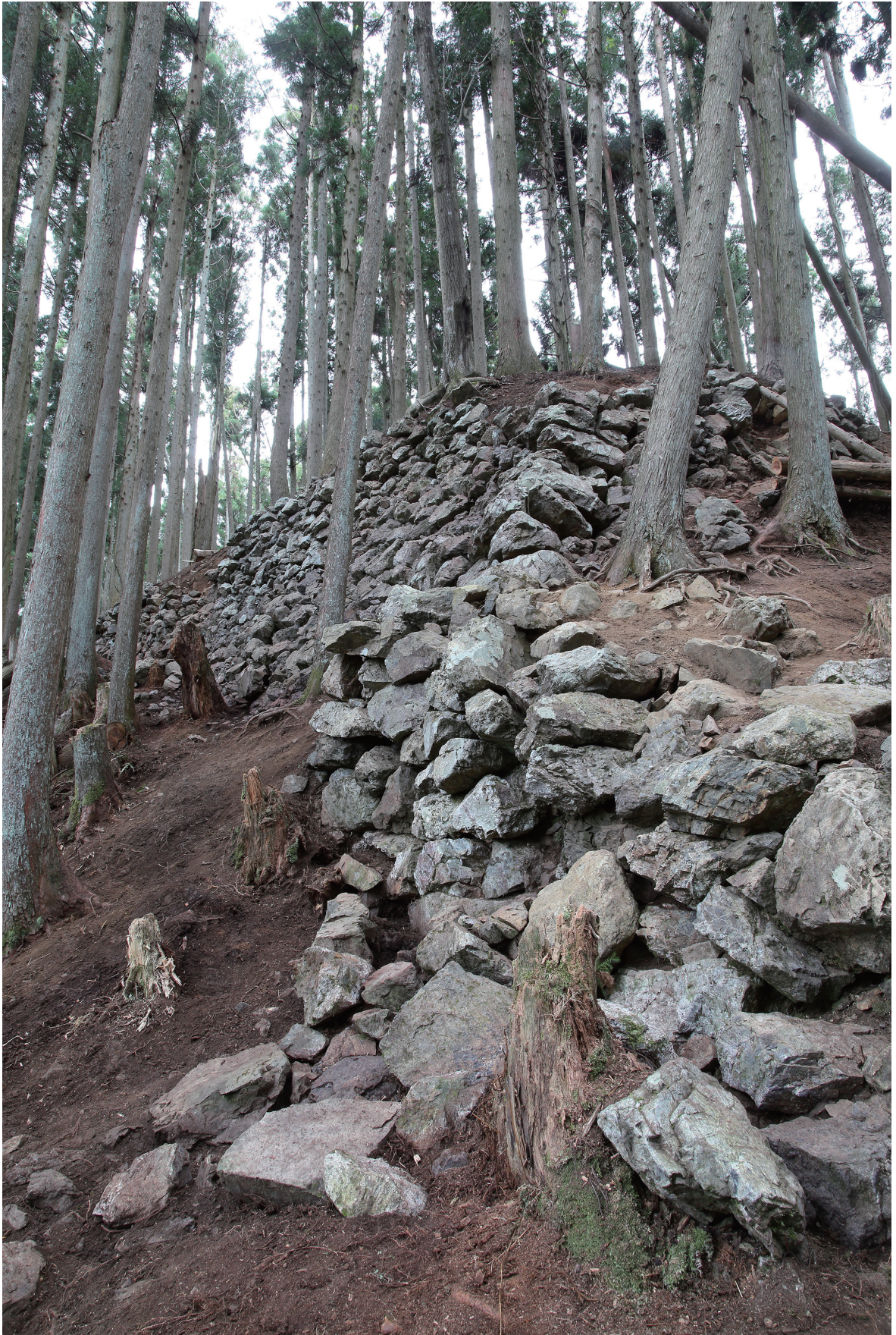
1 郭5北面・西面石垣（北西から）
