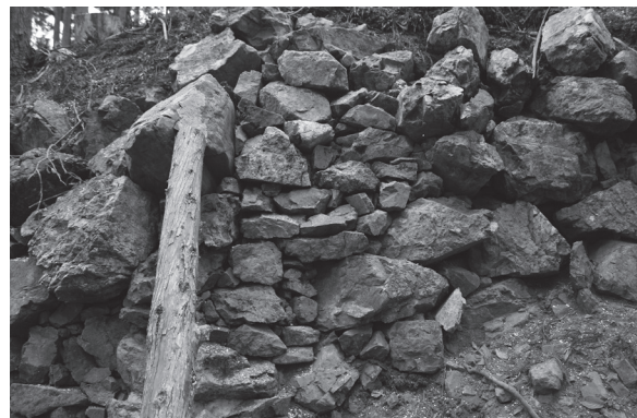
図26 補修箇所2（補修後）（西から）
