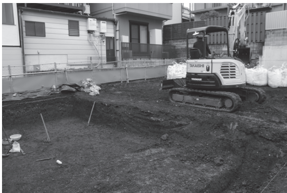
図5 1区埋戻し及び2区重機掘削（南東から）
