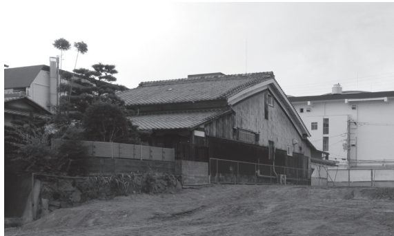
図5 隣地建物 (南東から)
