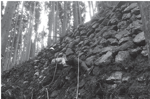
図4 石垣清掃作業風景（北西から）
