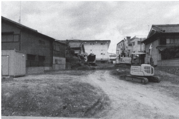
図6 調査前風景 (南から)
