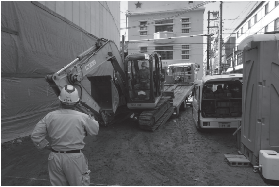
図2 重機搬入状況（北から）
