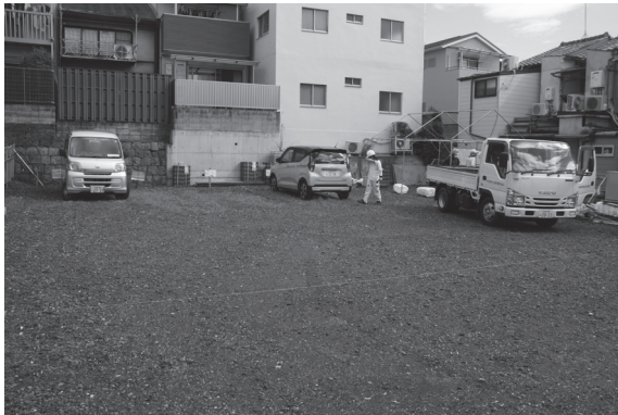
図3 調査前全景（南から）
