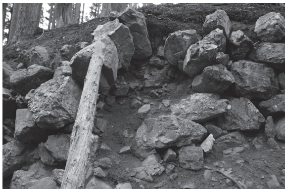
図25 補修箇所2（補修前）（西から）
