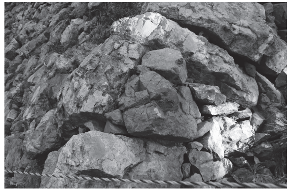
図24 補修箇所1（補修後）（西から）
