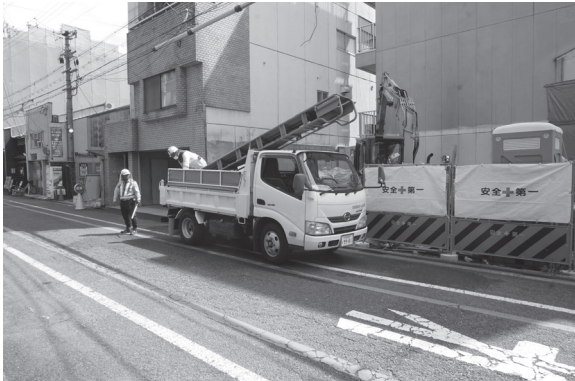
図4 器材搬出状況（南西から）
