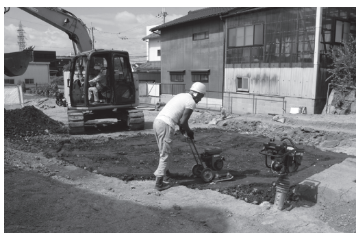
図8 埋戻し風景 (北東から)
