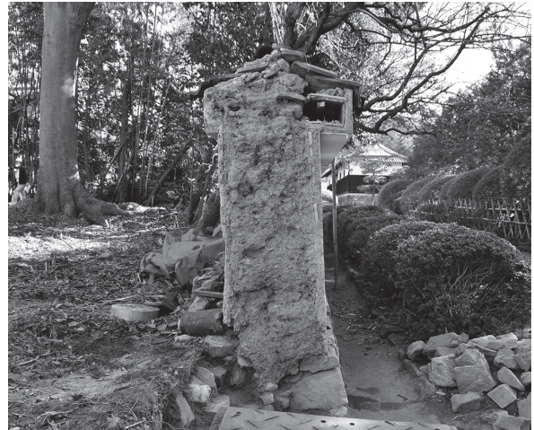
図 64 土塀断面 (西から)
